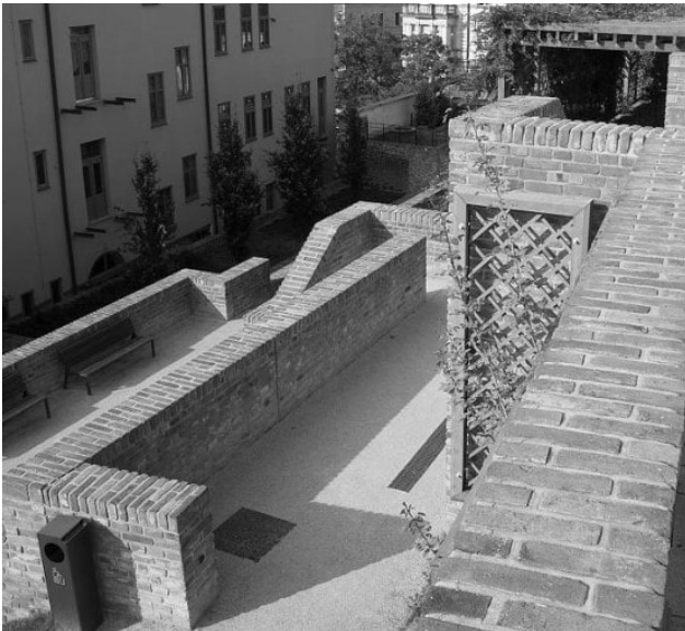
Obr. 66: Revitalizované hradecké jižní terasy
