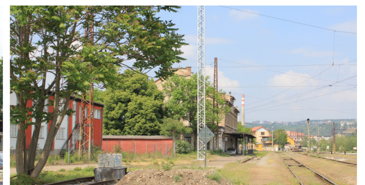
8. Pohled do prostoru stávajícího nádraží
