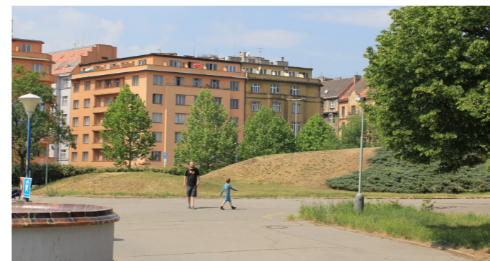
5. Střecha metra (garáží), park slouží venčení psů, lavičky nejsou umístěny
