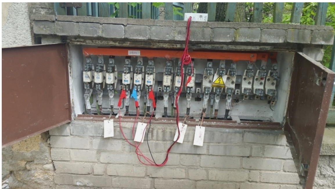
Obr. 24 RIS 61/162 a připojené měřicí zařízení
