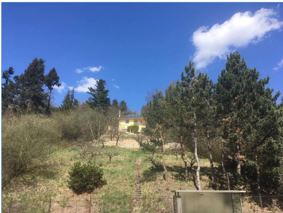
Obrázek 24: Novostavba rodinného domu s fotovoltaickými panely
