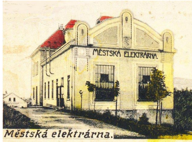
Obr. 4-1 Bývalá městská elektrárna v Nové Pace [12]
