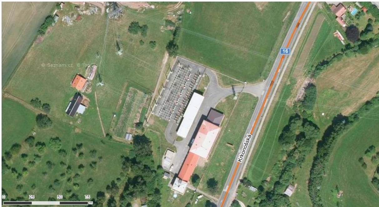
Obr. 4-2 Transformovna v Nové Pace, letecký pohled, Zdroj: Mapy.cz
