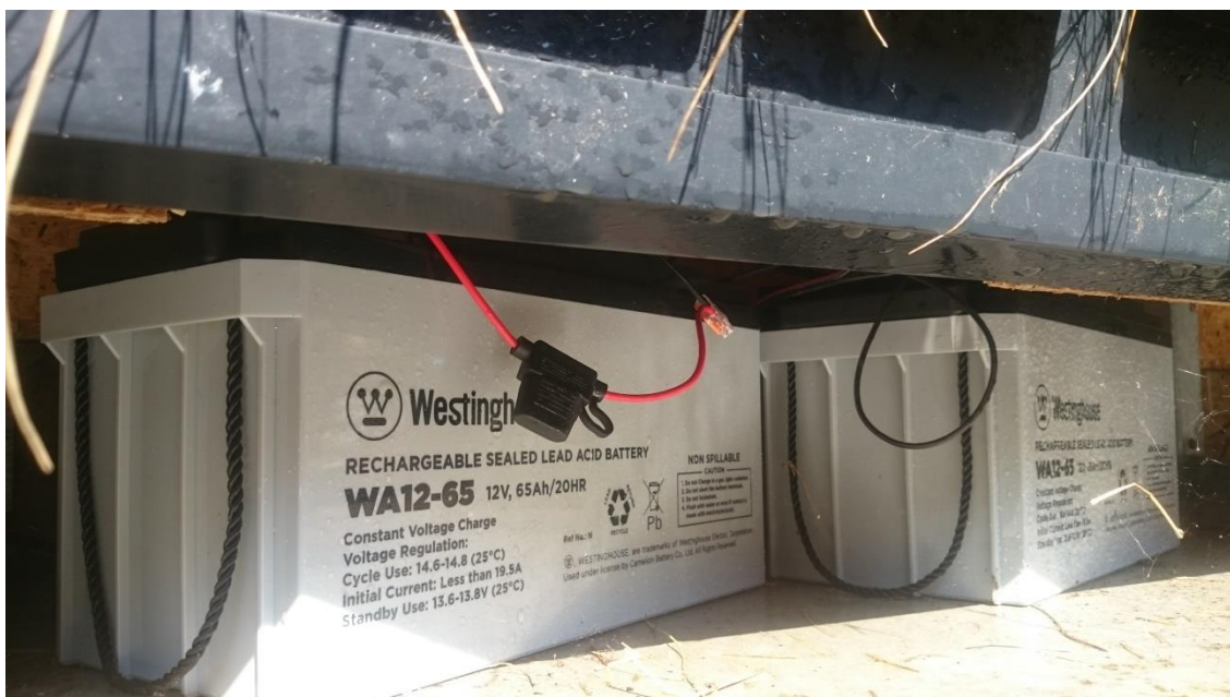
Obrázek 3.3 Akumulátorové baterie instalované do chytrých laviček s pojistkou proti zkratu
