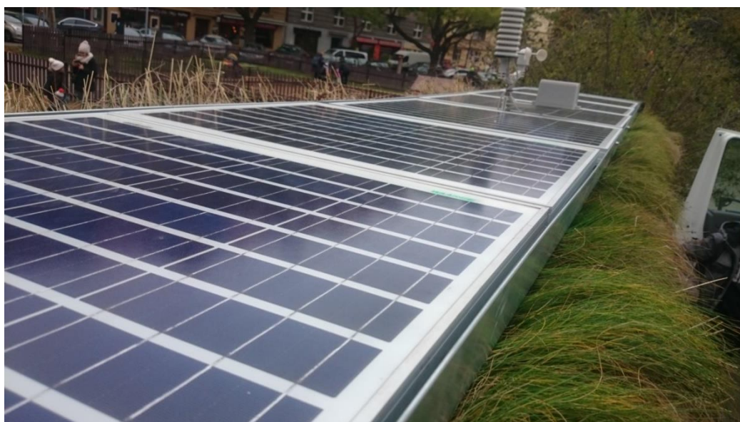
Obrázek 3.2 Střecha chytré lavičky na Puškinově náměstí se solárními moduly
