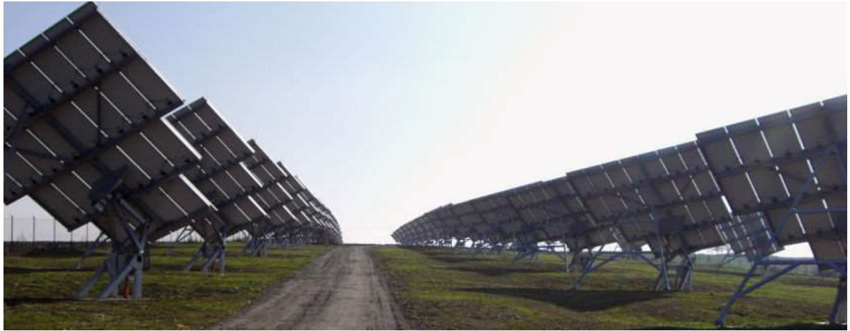
Obrázek 2.14: Polohovatelná konstrukce nosné části [2.7]
