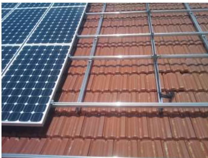
Obrázek 2.12: Konstrukce na sedlovou střechu [2.5]
