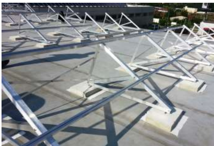
Obrázek 2.13: Konstrukce na rovnou střechu a volné prostranství [2.6]
