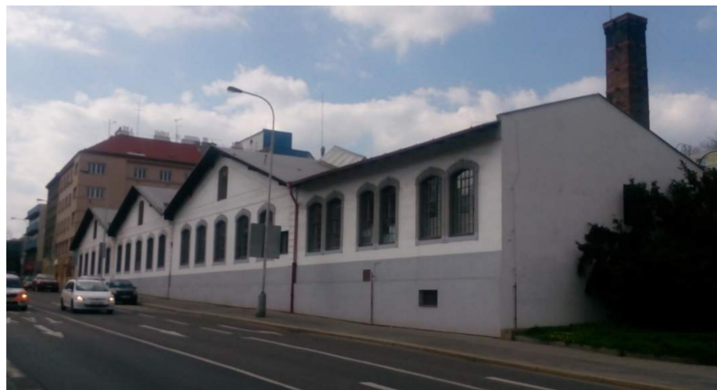
současný stav vozovny r. 2017
