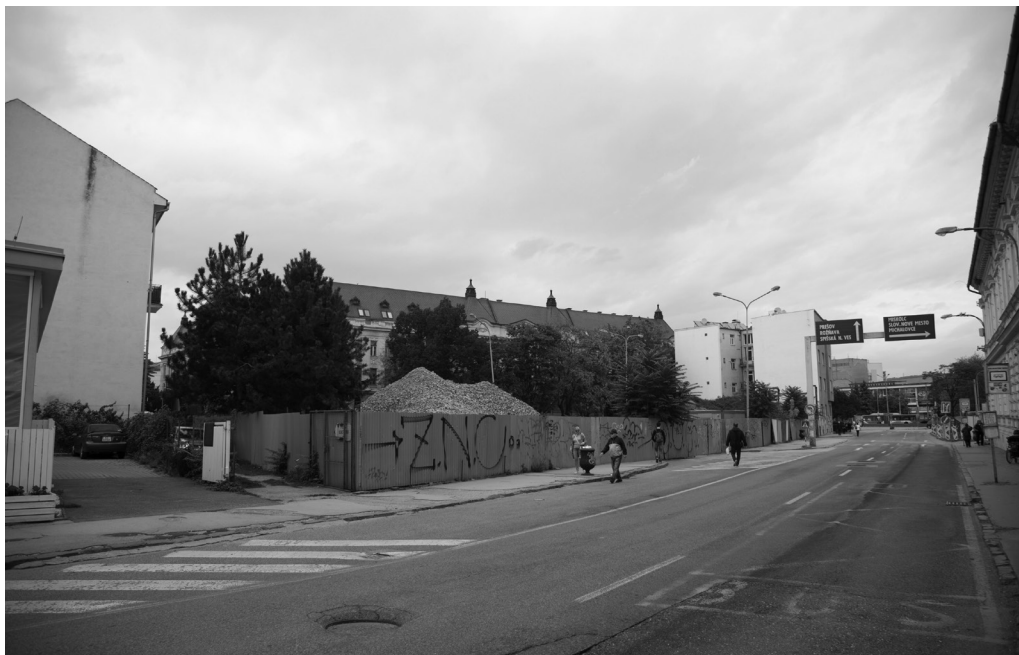
fotodokumentácia súčasného stavu
