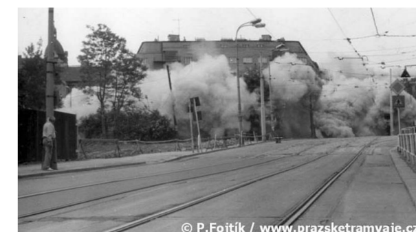
Demolice starých domů před stavbou metra. ▲
