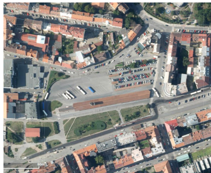
Ortofoto 2017. Autobusové nádraží dnes. Z bloků zbylo nároží mezi ulicemi Na Hrázi a Ronkova.
