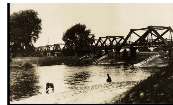
Provizorní dřevěný most, stavba 1903. ▲
