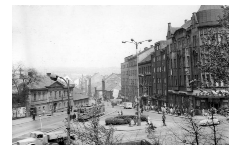
Palmovka, pohled do ulice Zenklova před stavbou metra. ▲
