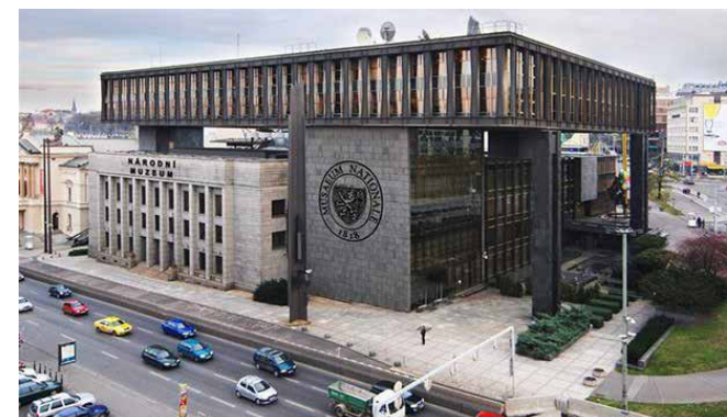
Budova Federálního shromáždění Karel Prager 1966-1973 - prvorepubliková burza byla doplněna o mostovou konstrukci, v té době největší na území státu
