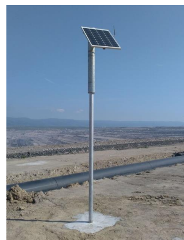
Obrázek 13 - Zařízení na pozorovaném bodě
