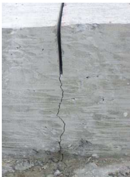
Obrázek 16. Smršťovací spára [24]
