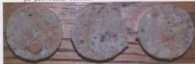
Obr.C99-113 Zkušební terče číslo 64, 65, 66 (zkušební místo 4) po provedení odtrhu.
