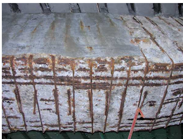
Obrázek 32. Koroze výztuže [1]
