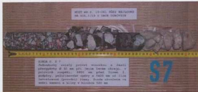
Obr.C99-100 Sonda č. S7. Dvojitý svislý průvrt vozovkou a částí přesypávky ø 50 mm při jejím levém okraji, v polovině rozpětí, 6600 mm před lícem 2. podpěry, pelhřimovské opěry a 5400 mm od líce levostranné (povodní) římsy. Sonda ukončena ve směsi kamení a hlíny v hloubce 520 mm.
