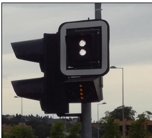
Obrázek 13 Světelné a výzvodové návěstidlo tramvaje
