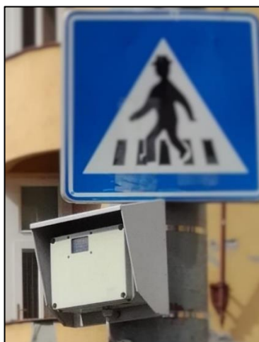
Obrázek 11 Inframaják umístěný na sloupu veřejného osvětlení
