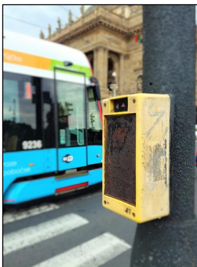
Obrázek 10 Umístění kontaktního zámku na sloupu SSZ.
