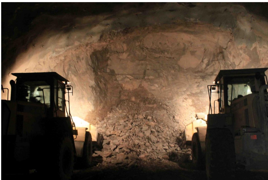
Obr. 7.8 Odtěžování za pomoci dvou nakladačů, které současně nakládaly rubaninu na dumpry. Šířka výrubu 11 m.
