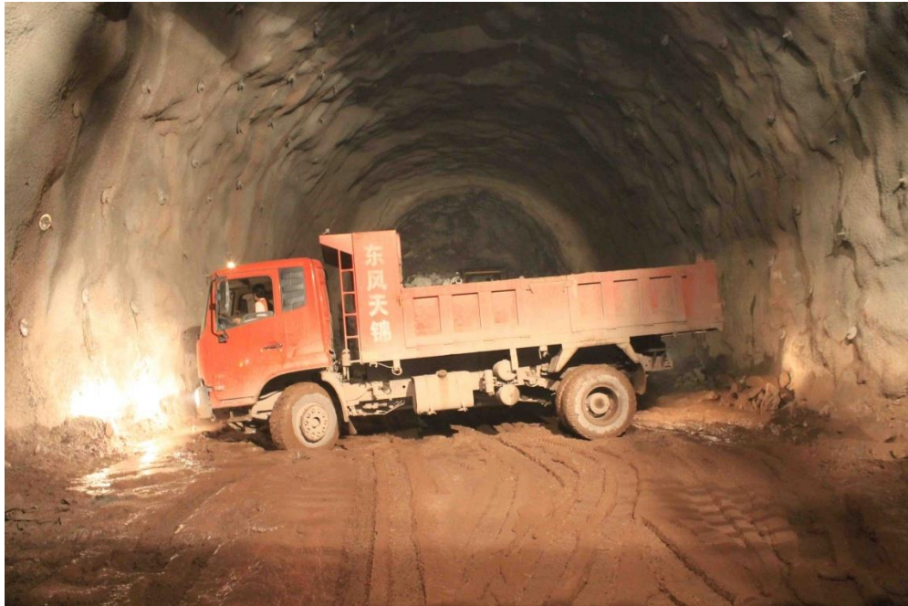
Obr. 7.9 Otáčení nákladního vozidla v tunelu před nacouváním k čelbě za účelem naložení rubaniny.
