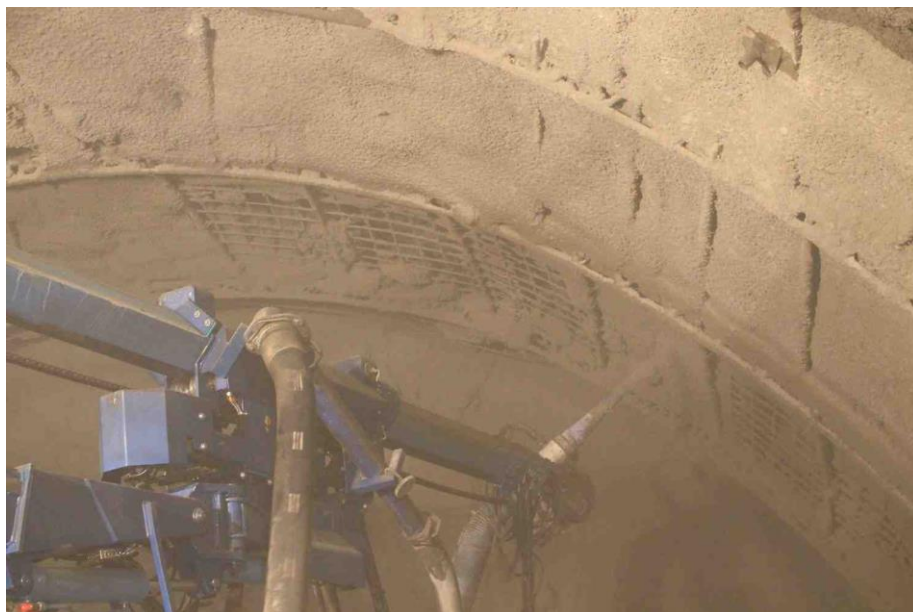
Obr. 7.20 Pracné a časové náročné vyfoukávání opadnutého betonu zpoza nainstalovaných ocelových sítí pomocí proudu vzduchu z trysky stříkací soupravy. V klenbě jsou patrné opadnuté kusy betonu zachycené za ocelovou sítí, které je třeba také odstranit.
