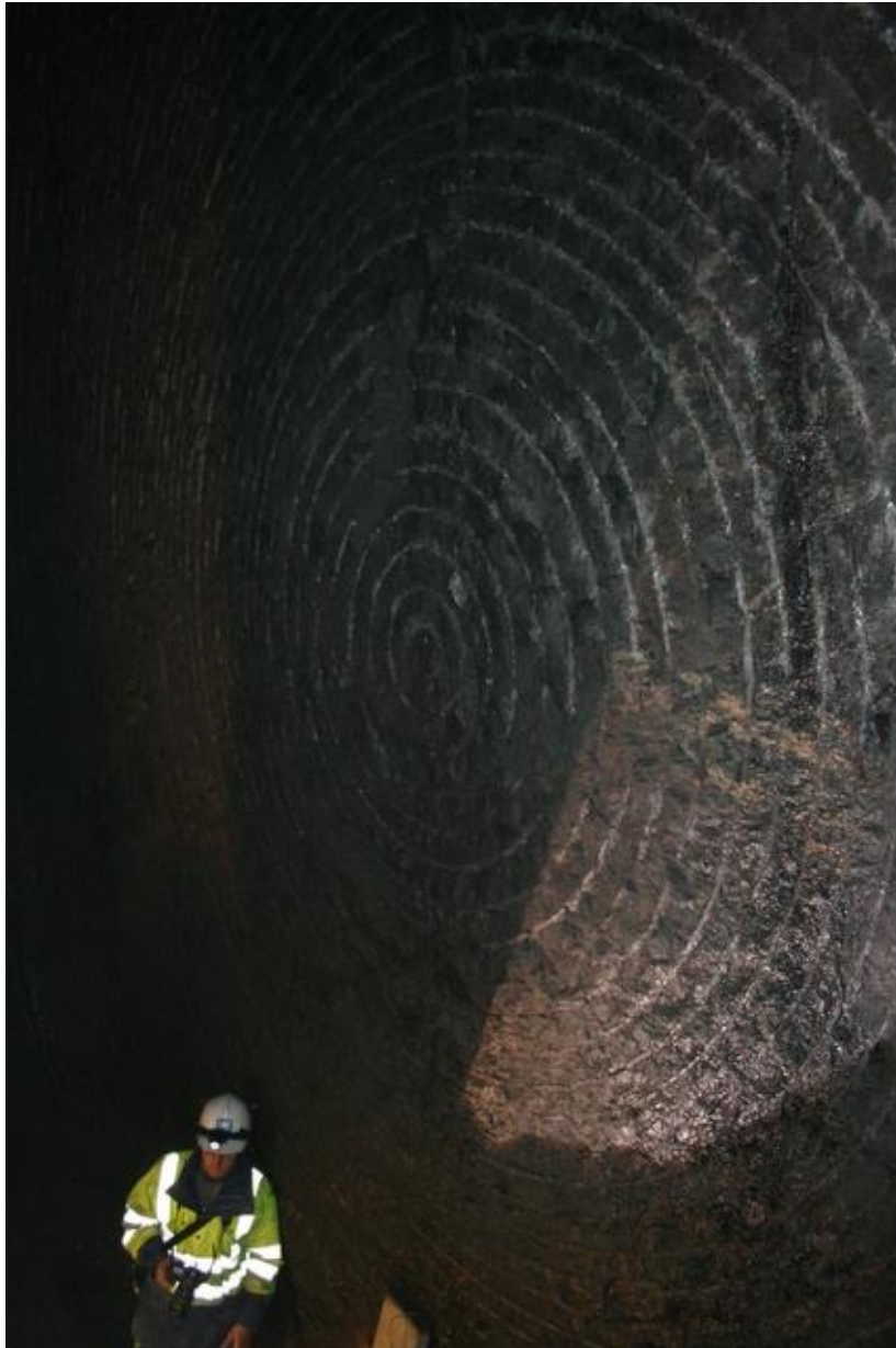
Obr. 9.1 Nepříliš časté mapování pěkně vysoustružené čelby v prostoru před řeznou hlavou, projekt Kárahnjúkar, příloha 1 a [8].
