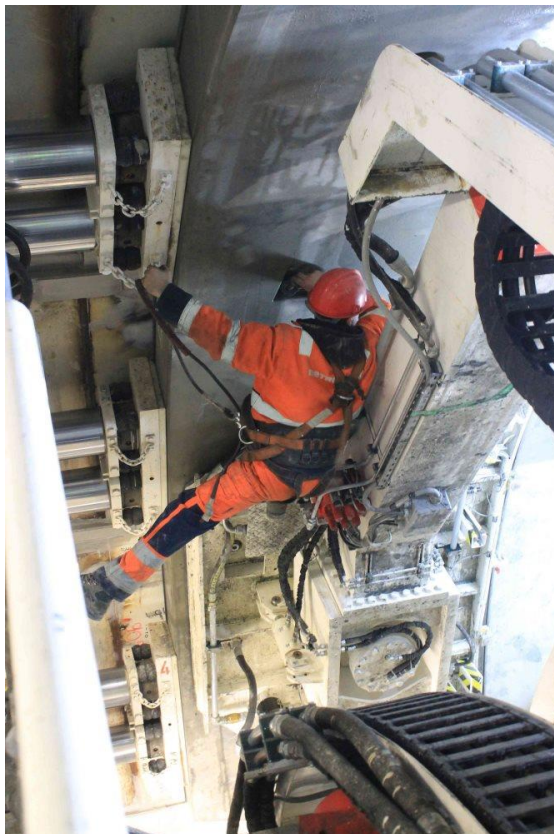
Obr. 7.39 Práce ve výšce při instalaci segmentů na pozicích 9 a 3 hod.
