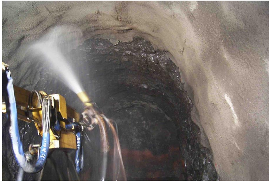
Obr. 7.25 Mytí povrchu tlakovou vodou z trysky stříkací soupravy před aplikací s/b.
