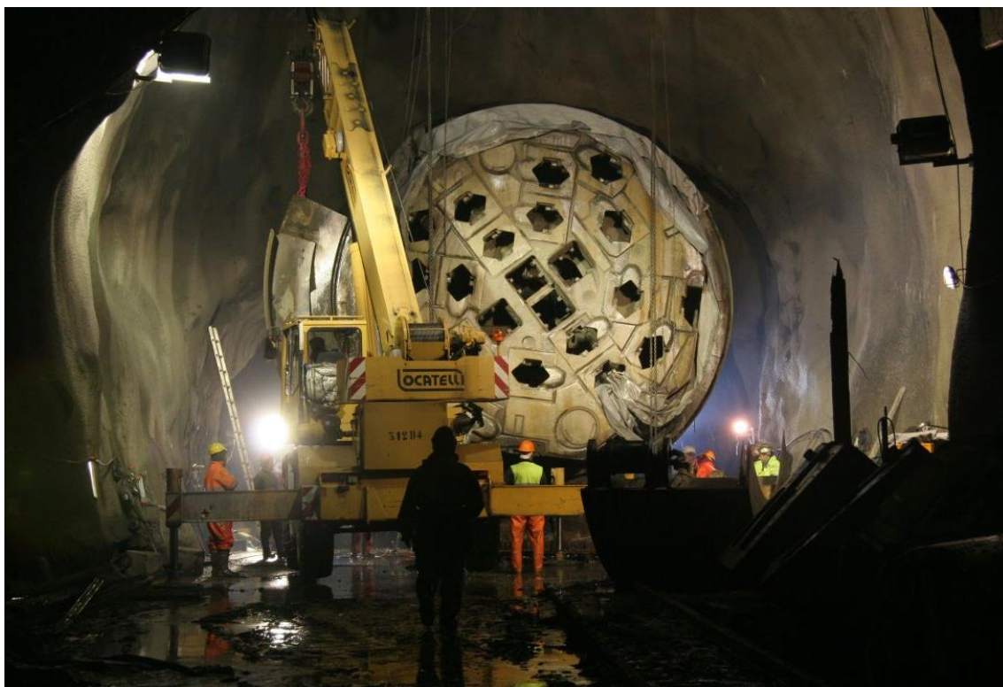
Obr. 9.4 Demontáž TBM 1 v podzemní kaverně poté, co úspěšně vyrazilo přes 14 km hlavního přivaděče, projekt Kárahjúkar, příloha 1 a [8].
