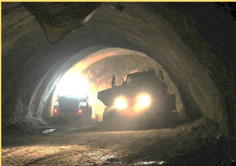
Obr. 7.16 Probíhající nakládka dampru na čelbě, dostatečné osvětlení a větrání [1].
