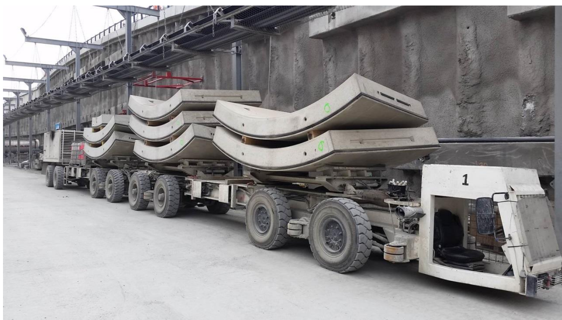
Obr. 7.34 Segmenty (7+1 ks) naložené na msv před portálem, projekt Ejovice, příloha 5.
