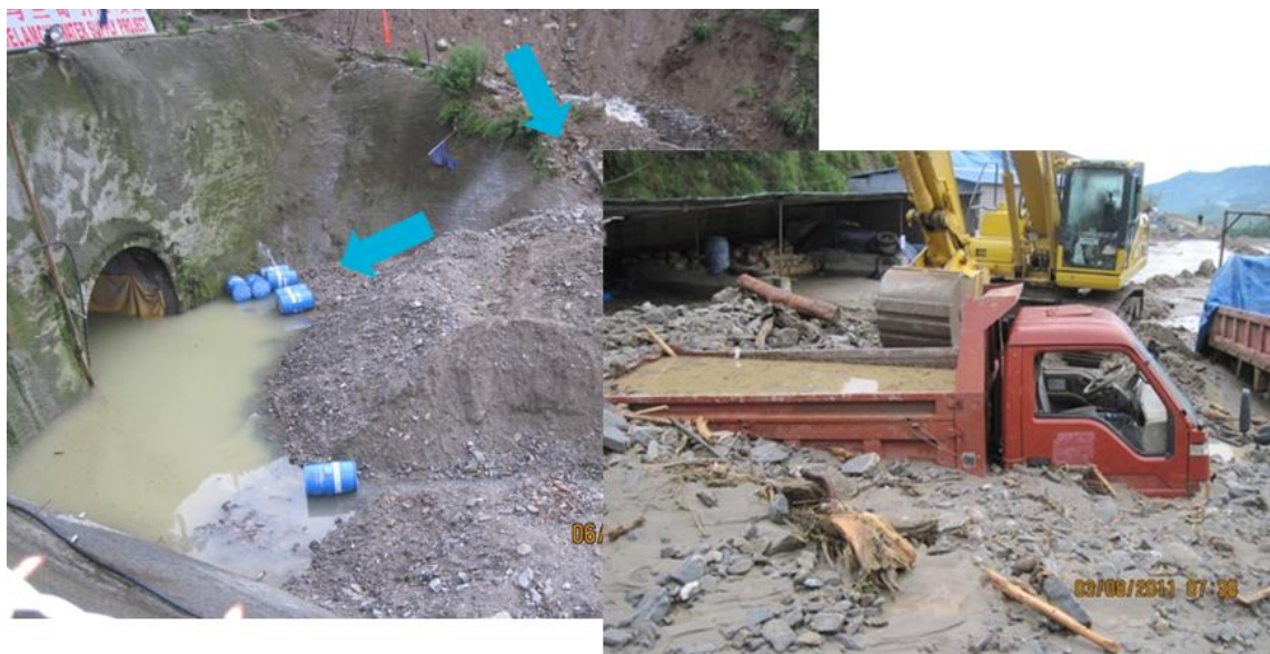
Obr. 4.16 Podmínky stavby – svahové sesuvy - zatopení tunelu a staveniště, projekt Melamchi, Příloha 2.
