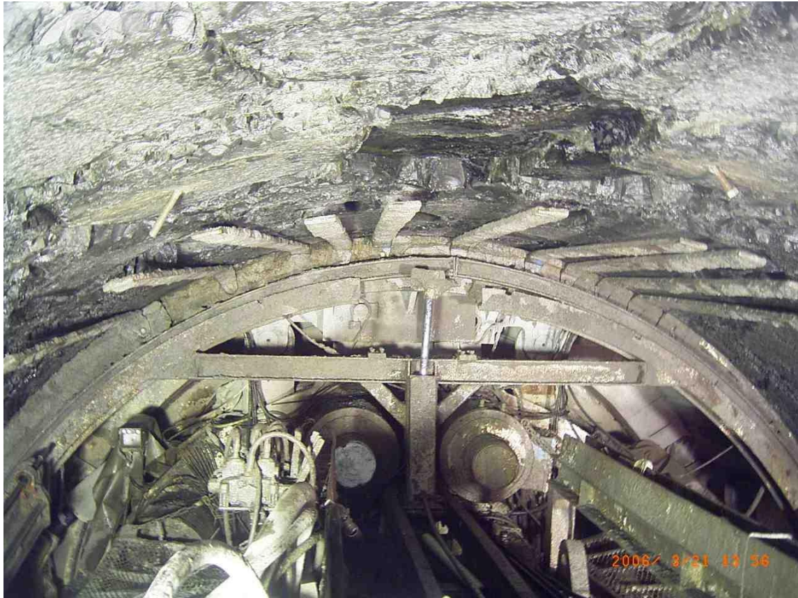
Obr. 9.2 Prostoru za řeznou hlavou, horninový masiv velmi dobré kvality, ojediněle odlučnost desek v klenbě podél ploch nespojitosti – lokálně instalované svorníky, projekt Kárahjúkar, příloha 1 a [8].
