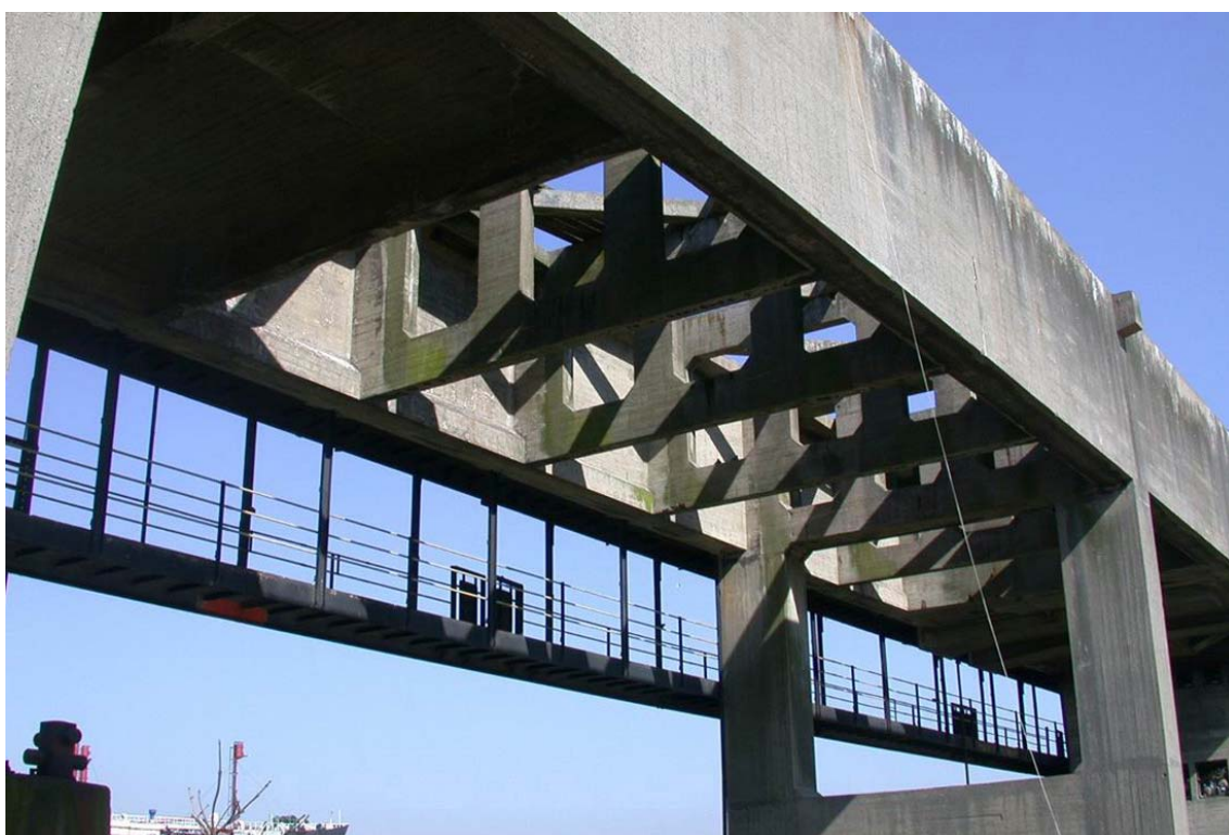
obr. č. 5-39 | původní betonová konstrukce. © OTH Architecten. Zdroj: http://www.archdaily.com/2967/kraanspoor-oth-ontwerpgroep-trude-hooykaas-bv
