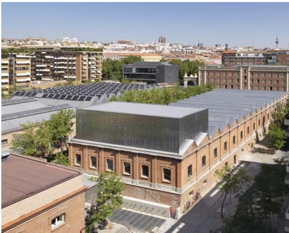
obr. č. 5-10 | renovovaná pilová střecha. © Alfonso Quiroga Zdroj: https://www.plazatio.com/es/proyecto/centro-cultural-daoiz-y-velarde
