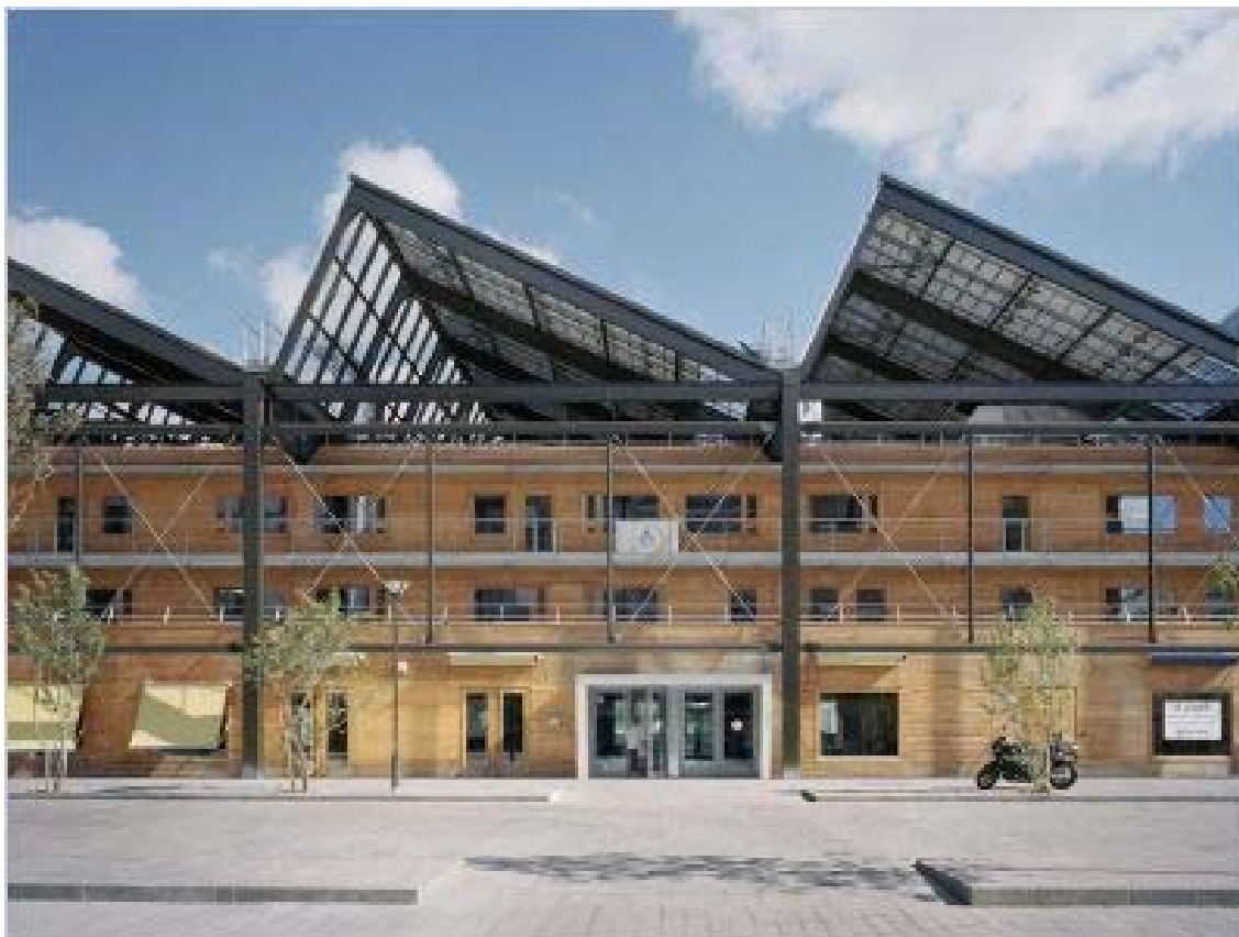
obr. č. 5-24 | pilovitá střecha nesoucí fotovoltaické panely. © Axel Tilche. Zdroj: http://www.batiactu.com/edito/halle-pajol-36286.php
