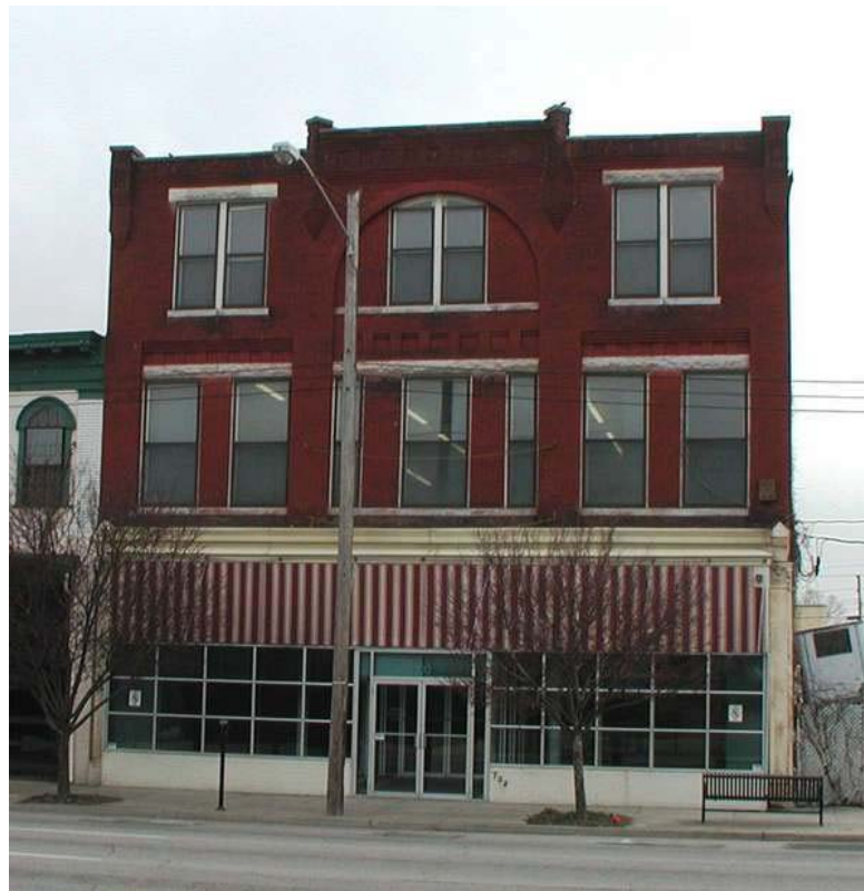
obr. č. 5-54 | původní podoba průčelí skladu před rekonstrukcí. Zdroj: https://www10.aecafe.com/blogs/arch-showcase/2011/03/25/the-green-building-in-louisville-kentucky-by-fer-studio/
