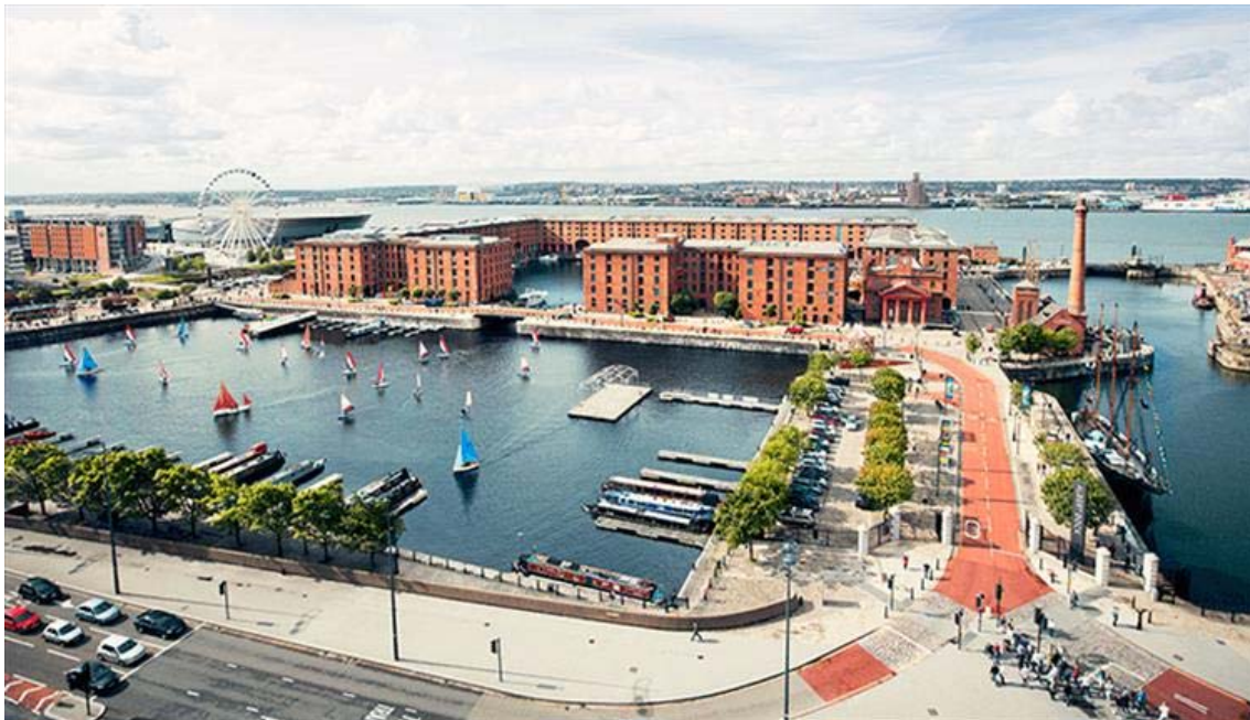
obr. č. 3-13 | Albert Dock | Liverpool, revitalizace rozsáhlého území bloků, dnes atraktivní promenáda. Zdroj: https://www.visitliverpool.com/things-to-do/the-albert-dock-p16143
