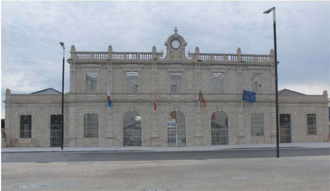
obr. č. 5-17 | opravené zachované průčelí. ( http://casa-mediterraneo.es/conoce-nuestra-sede-antigua-estacion-benalua/ )
