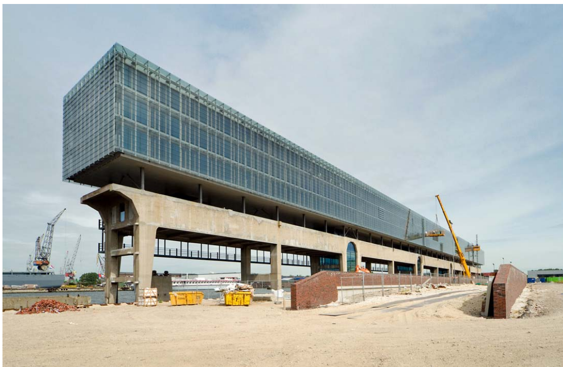
obr. č. 5-38 | objekt během výstavby. © OTH Architecten. Zdroj: http://www.archdaily.com/2967/kraanspoor-oth-ontwerpgroep-trude-hooykaas-bv
