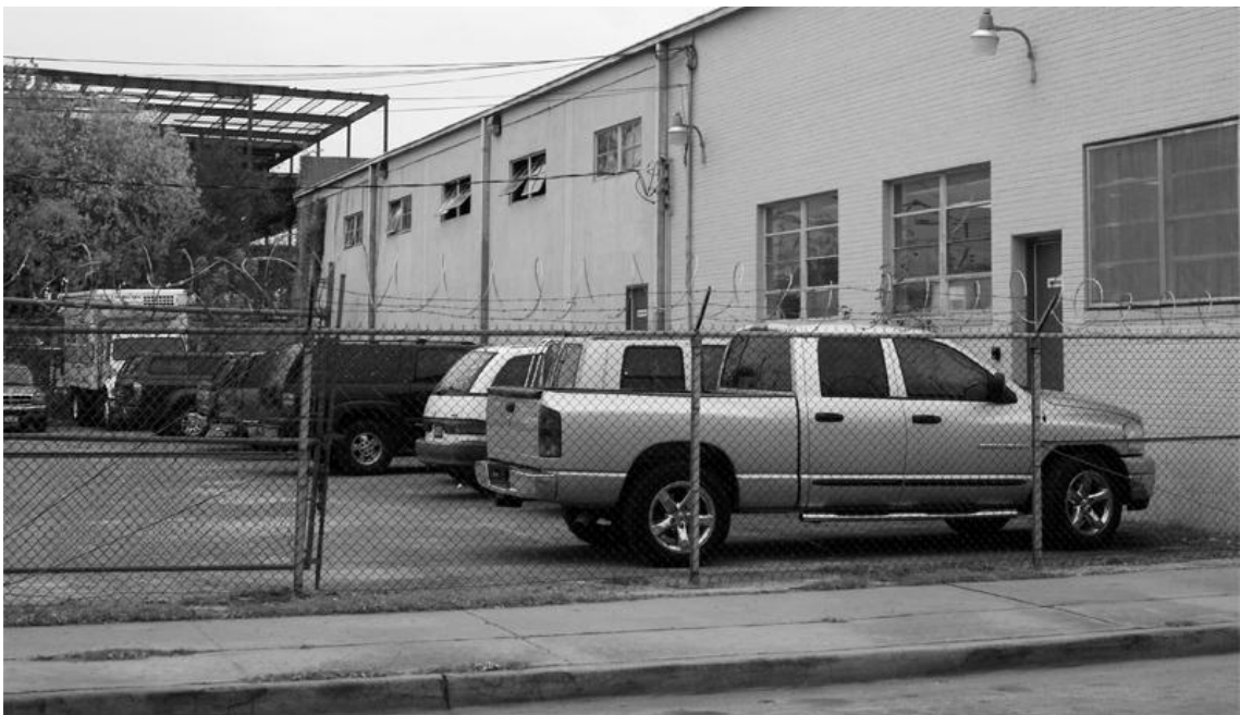
obr. č. 5-48 | původní podoba, ohraničení pozemku, asfaltové parkoviště. © Hester + Hardaway. Zdroj: http://www.aiatopten.org/node/100
