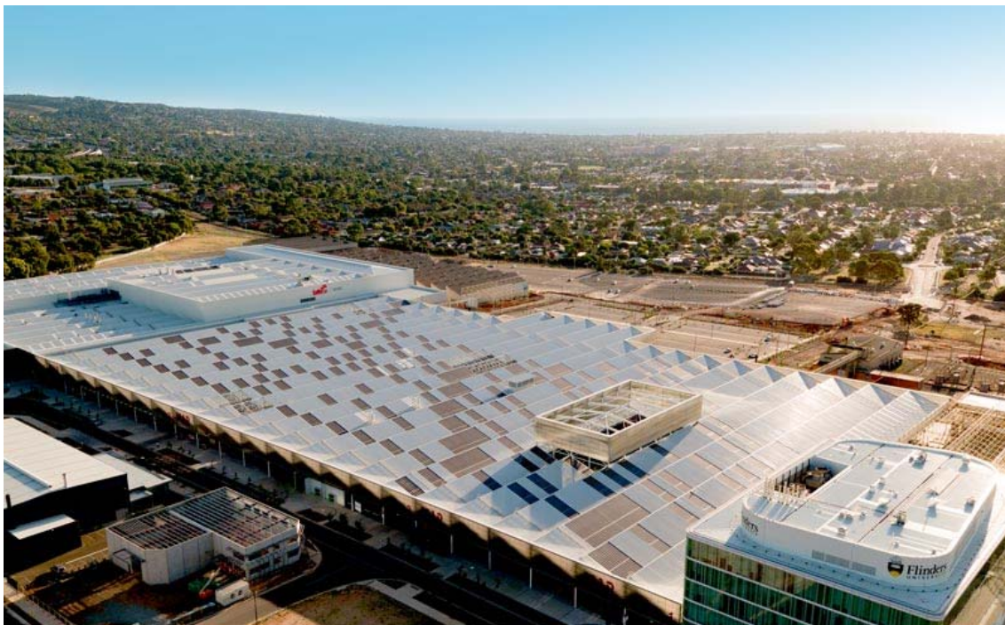
obr. č. 5-68 | původní střešní konstrukce s fotovoltaickými panely. Zdroj: https://www.woodsbagot.com/projects/tonsley-park-redevelopment-main-assembly-building-and-pods
