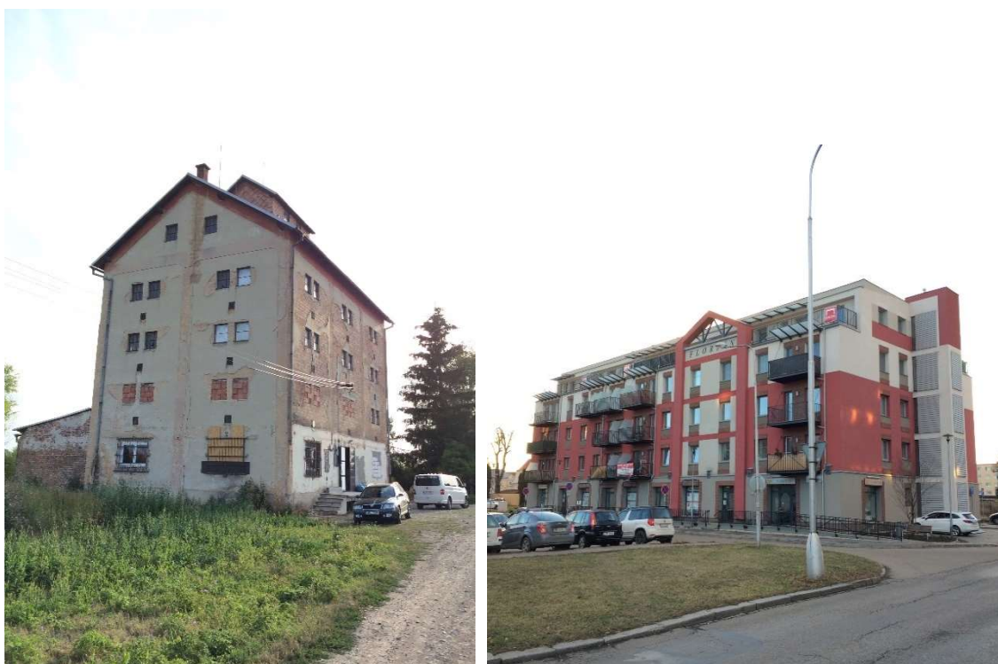
obr. 12 Stavby zařazené do kategorie standartních objektů - vlevo Obilní skladiště Hospodářského družstva v Litovli; v současnosti se přestavuje na ubytovací zařízení a hudební klub; vpravo Městský pivovar v Prostějově, později výroba knoflíků Kornolith; v současnosti přestavěn na byty. Foto zdroj: Daniela Bilan
