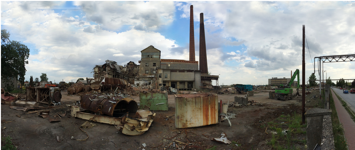
obr. 25 Rolnický akciový pivovar a rafinerie v Brodce u Přerova - v průběhu bouracích prací Foto zdroj: Daniela Bilan
