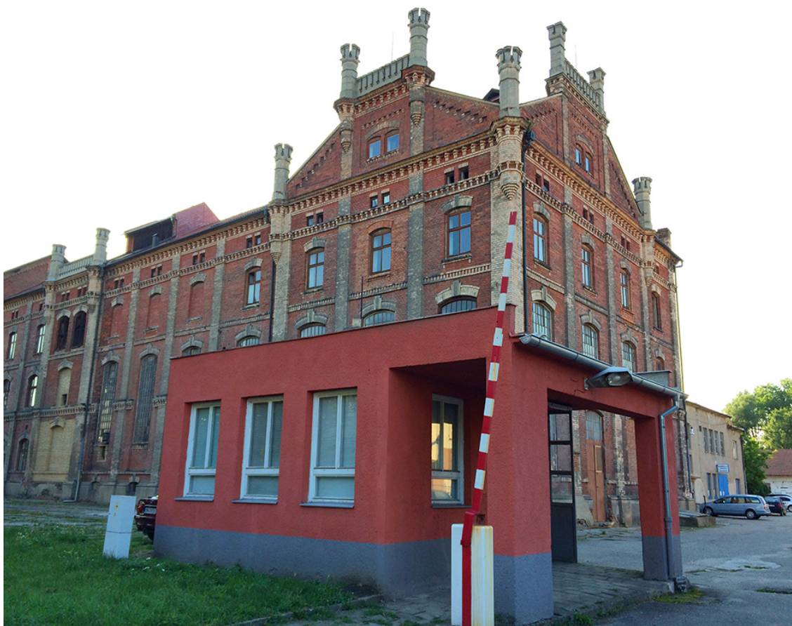
obr. 14 Akciový pivovar v Prostějově ( jedinečný objekt ), který by zasluhoval památkovou ochranu, je u vjezdu nevhodně zastíněn budovou vrátnice ( podprůměrný objekt ) Foto zdroj: Daniela Bilan
