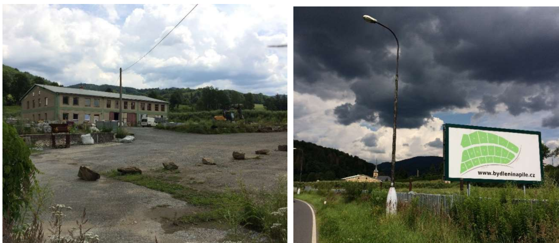
obr. 13 Parní pila Jeseník Bukovice - areál pily byl v roce 2017 zbourán a zůstal jen jeden obslužný objekt, který je přestavěn na dílny. Zbytek území je rozparcelováno a bude zde individuální bydlení. Foto zdroj: Daniela Bilan
