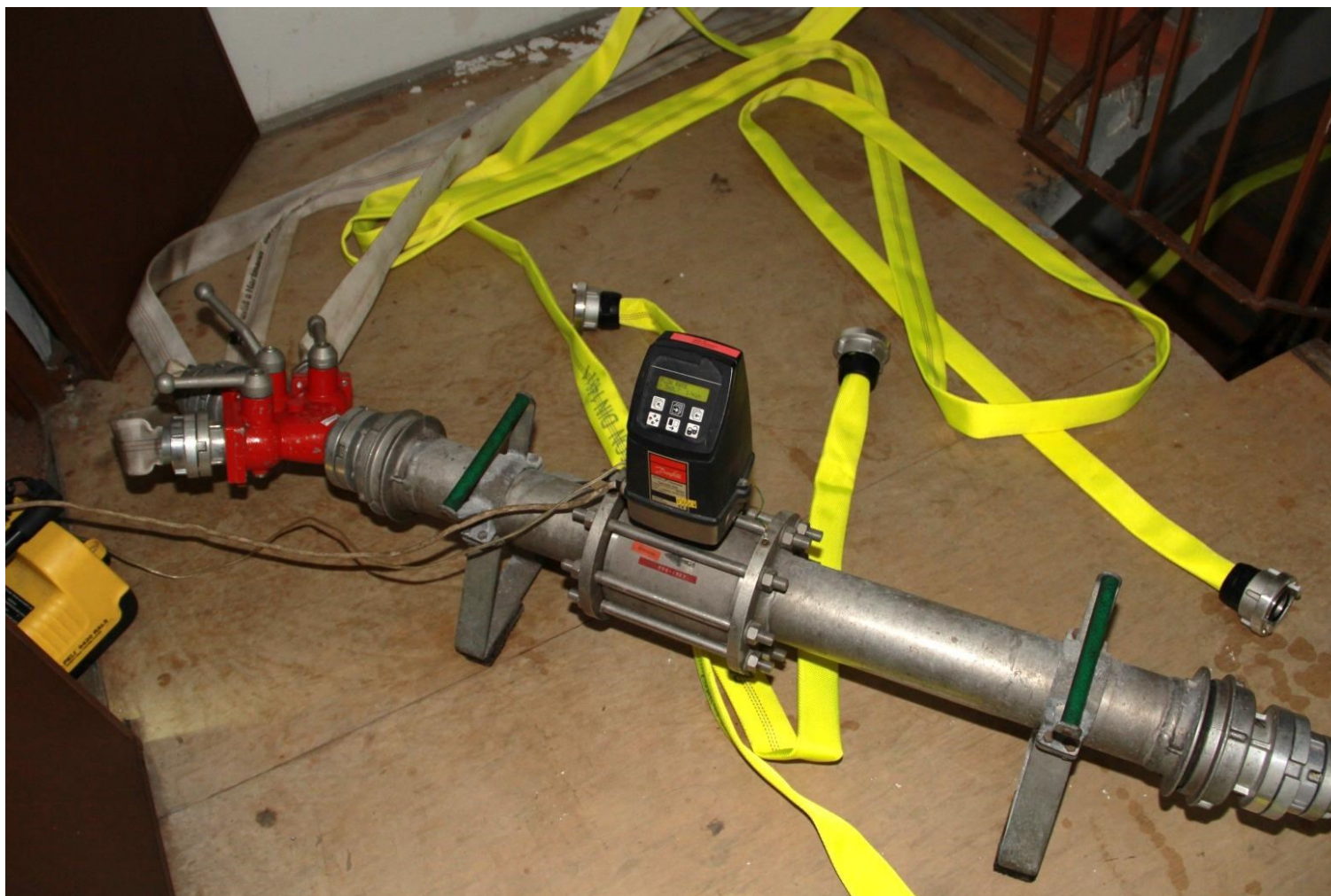
Obr. 28 – Příprava měřicí soustavy při měření s výškovým převýšením v hotelu Opatov v pátém nadzemním podlaží
