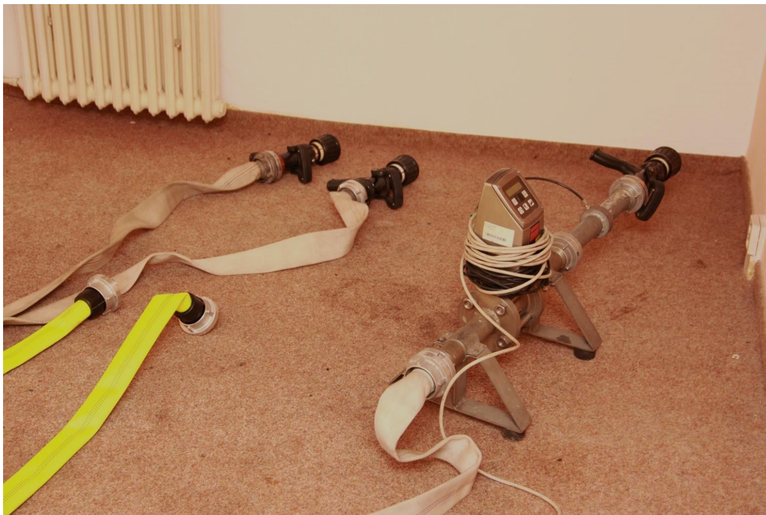
Obr. 31 – Příprava měřicí soustavy na ÚP při měření s výškovým převýšením v hotelu Opatov v šestém nadzemním podlaží
