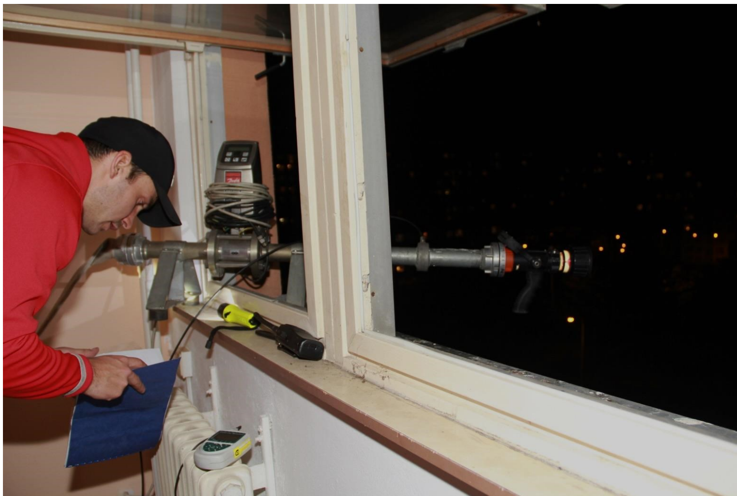
Obr. 32 – Příprava měřicí soustavy a zápisu dat na ÚP při měření s výškovým převýšením v hotelu Opatov v šestém nadzemním podlaží
