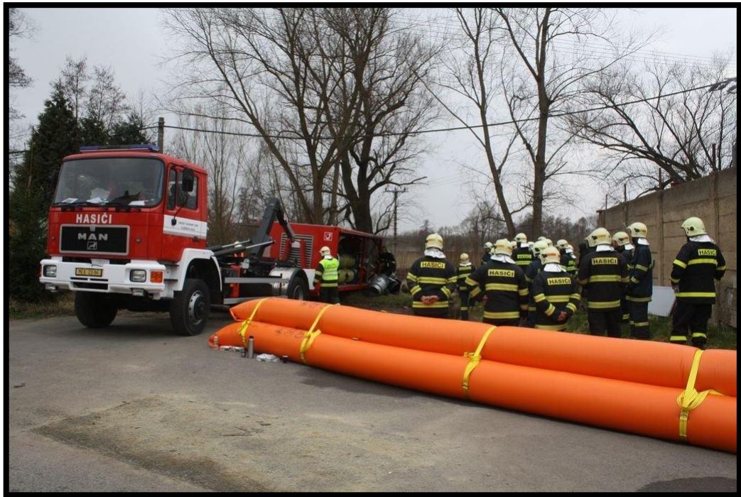
Obrázek 20 Postavená protipovodňová zábrana a ustavení MČS 400 (vlastní zdroj)
