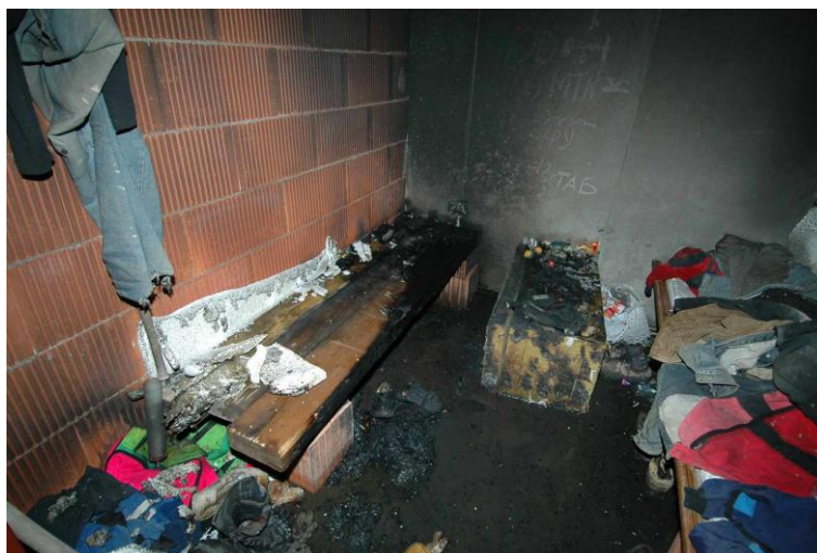
Obrázek 19 Následky požárů způsobené odkládáním hořlavin na topidlo [44]
