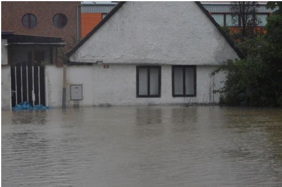
Foto 5 Lokalita Bačov, ulice Jeronýmova - objekt po povodni určen k demolici
