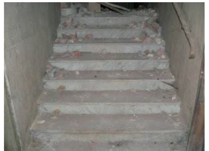
Mramorové schodiště do restaurace
