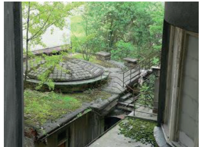
Prosvětlovací kopule ve dvorním traktu
