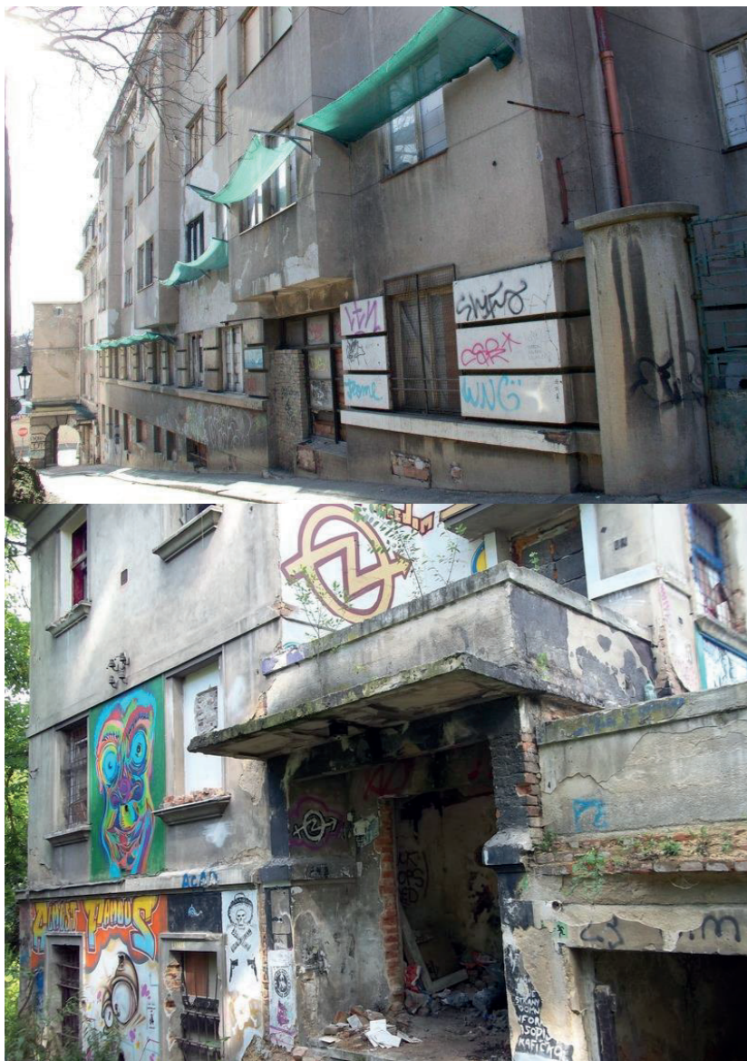
Chátrající dům v centru Prahy – Na Slupi 434/8
