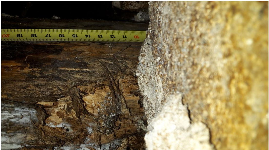
Obrázek 14: Sonda A - Trám č. 2 - hloubka uložení
