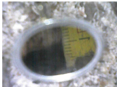
Obrázek 33: Sonda D - Trám č. 2 - čelo trámu, endoskopem
