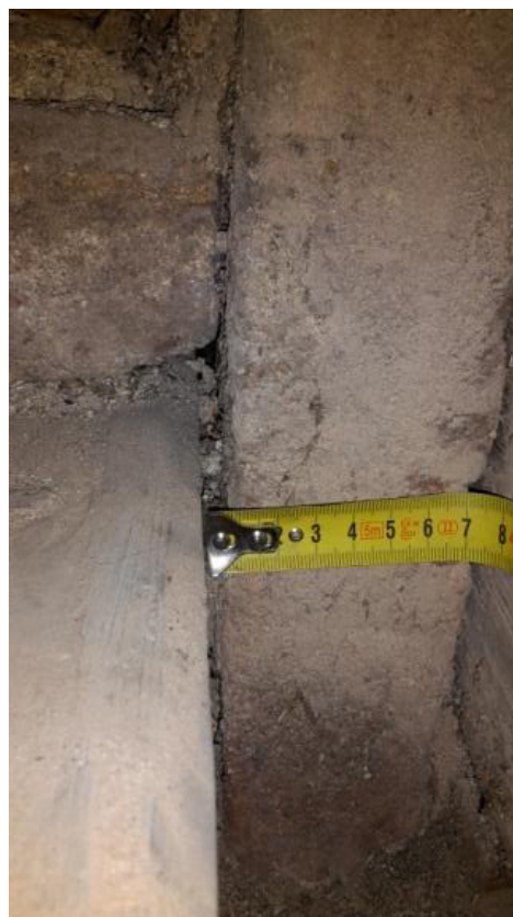
Obrázek 29: Sonda D - Trám č. 1
