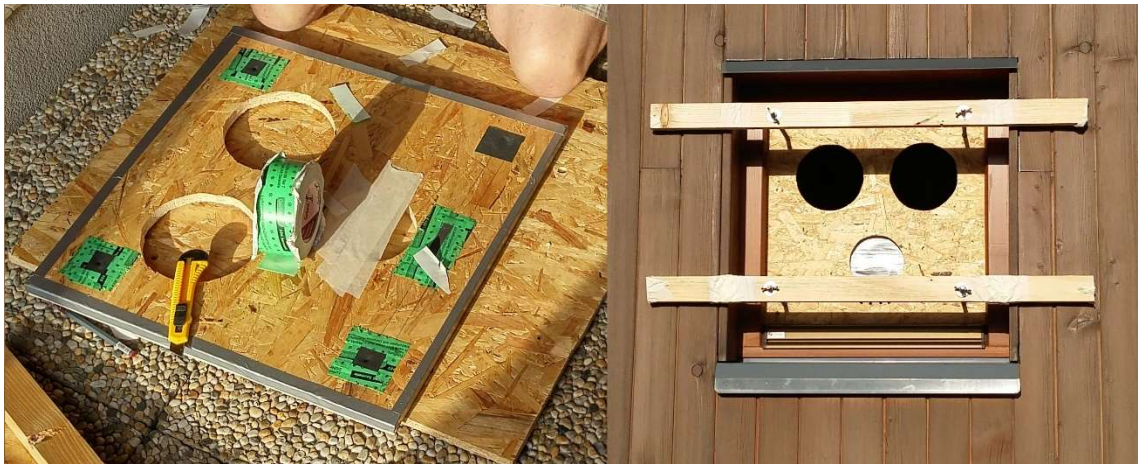
Obrázek 9: Výroba clony a její osazení do okna koupelny
