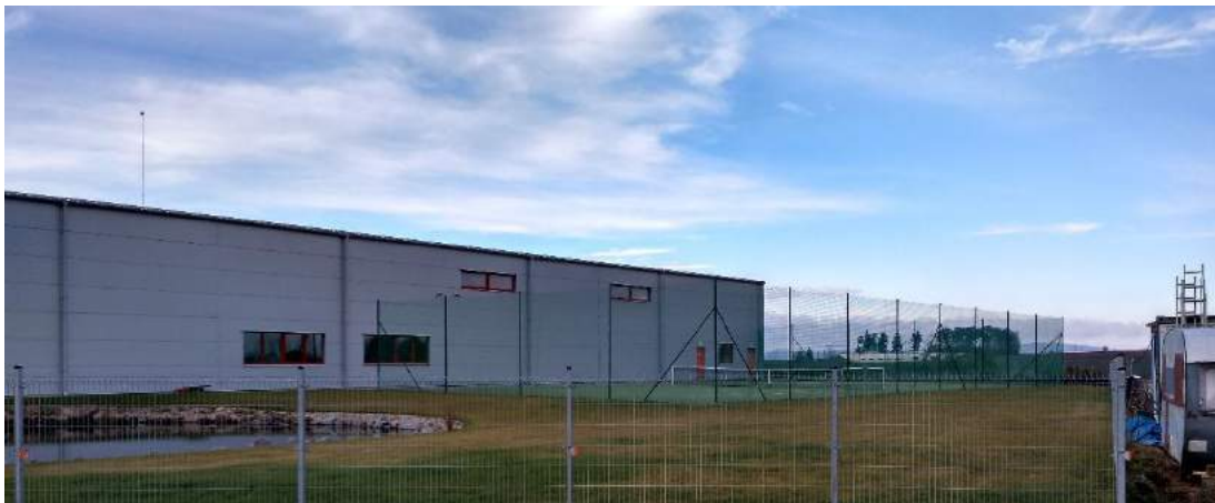
Obr. 10 - Retenční nádrž požární vody a sportoviště (Foto: Autor)
