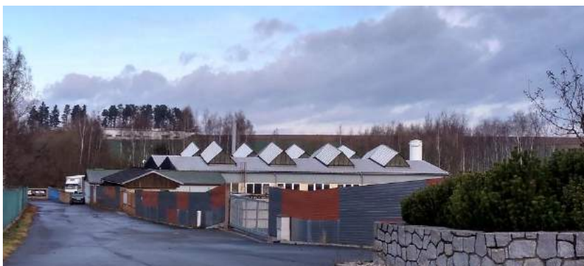
Obr. 2 - Jižní pohled na stávající výrobní halu z příjezdové cesty (Foto: Autor)
