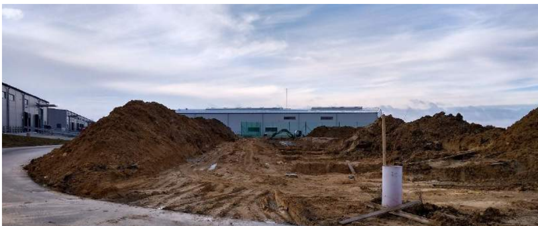
Obr. 11 - Výstavba haly v nové části zóny (Foto: Autor)
