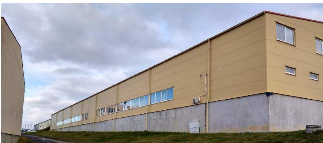
Obr. 8 - Typický model haly s opláštěním z PUR panelů, s přirozeným větráním pásovými okny a dešťové svody vyústěné do kanalizace (Foto: Autor)
