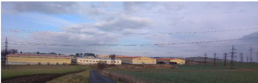
Obr. 6 - Celkový pohled na novou část průmyslové zóny (Foto: Autor)
