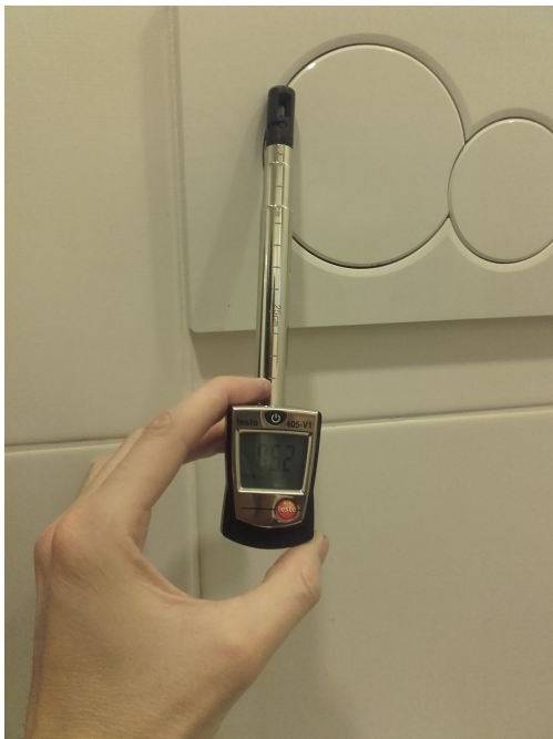
Ilustrace 8: Detekovaná netěsnost - ovládání splachování toalety (0,52 m/s)
