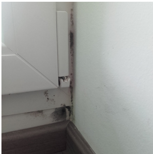
Ilustrace 26: Tvorba plísně okolo pantu balkonových dveří [4]
