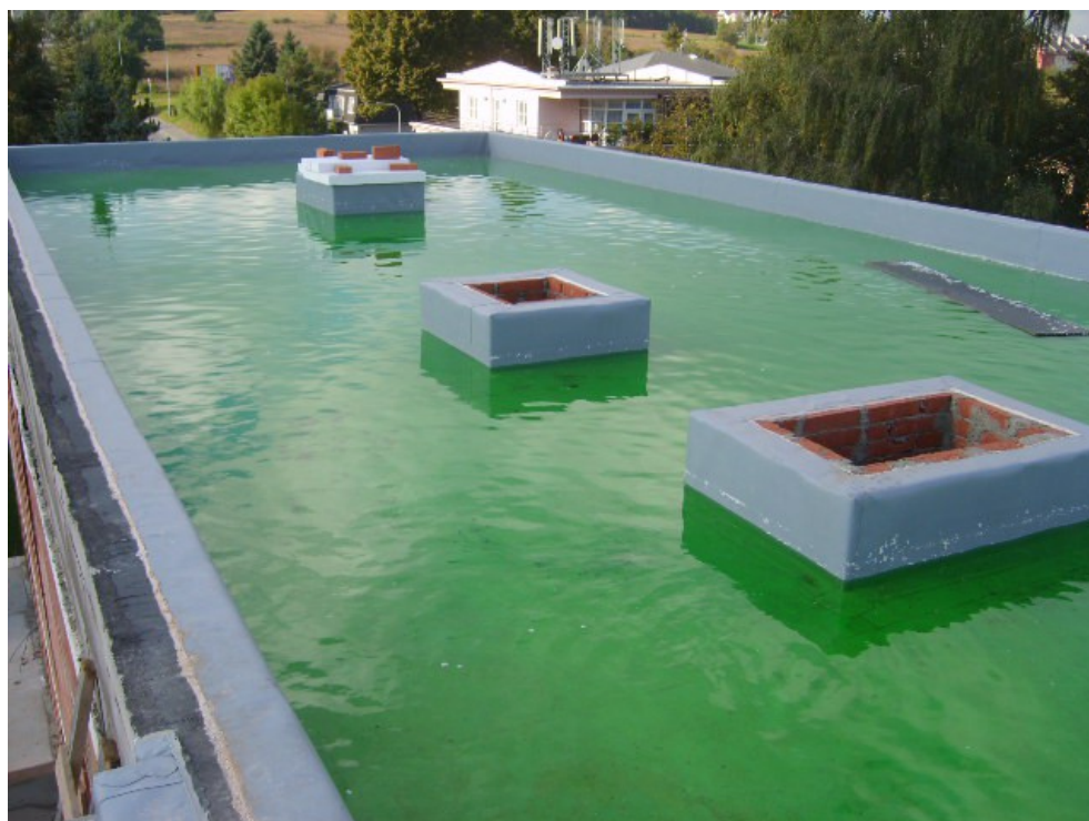
Ilustrace 3: Zátopová zkouška ploché střechy (převzato z [28])
