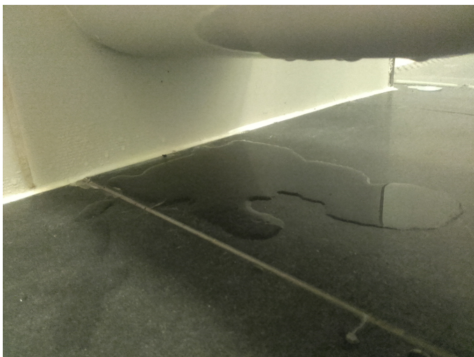
Ilustrace 28: Kondenzát pod záchodovou mísou[4]
