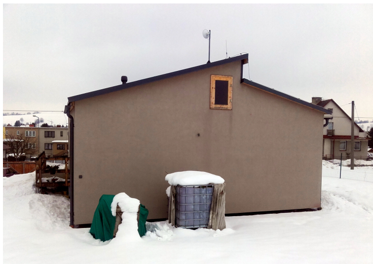
Ilustrace 25: Pohled na objekt ze severovýchodu, [4]
