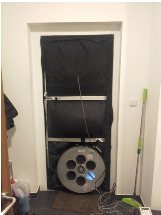
Ilustrace 31: Osazení otvoru vstupních dveří ventilátorem [4]
