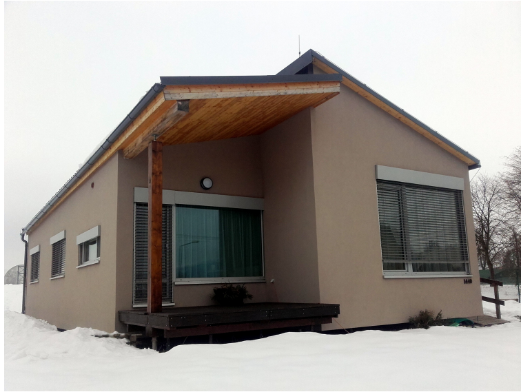
Ilustrace 23: Pohled na objekt ze západu, [4]
