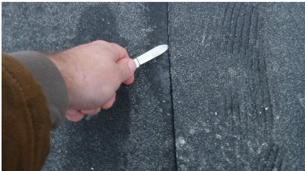
Ilustrace 1: Zkouška spoje asfalt. pásů špachtlí resp. obdobným nástroje [4]
