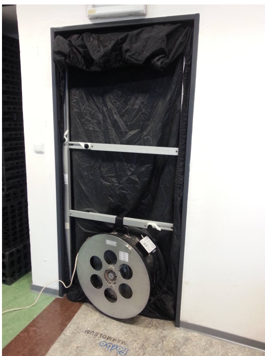
Ilustrace 13: Osazení ventilátoru pomocí teleskopického rámu a plachty [4]
