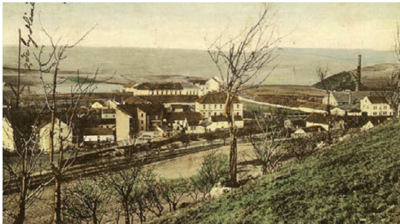
pohled na Vokovice ze svahu nad tratí, bloky domů byly asanovány při výstavbě ulice Evropská [6]
