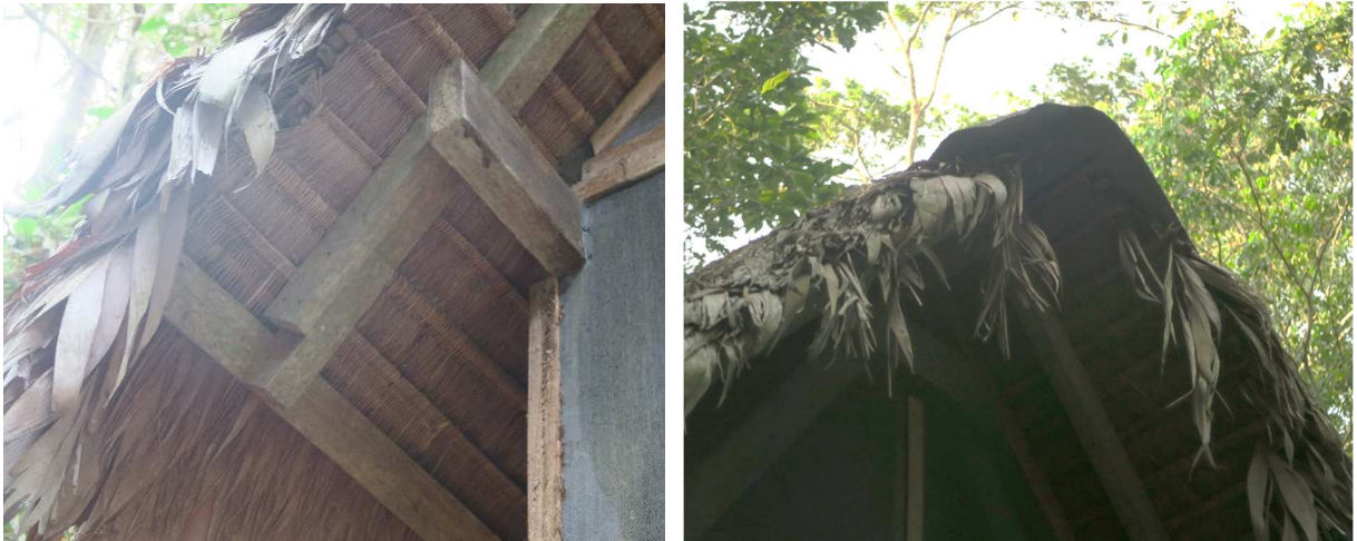
Obrázek 20 - Vlevo: Kladení plátů jataty; Vpravo: zajištění vrcholu střechy (vlastní fotografie)
