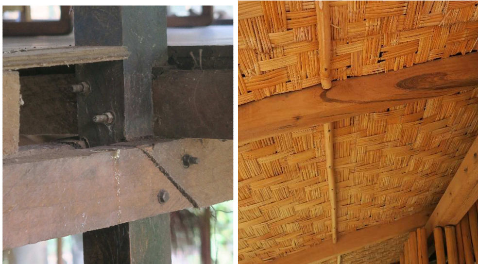
Obrázek 22 – Vlevo: Spojování pomocí svorníků; Vpravo: Použití hřebíků na sekundární konstrukce (vlastní fotografie)
