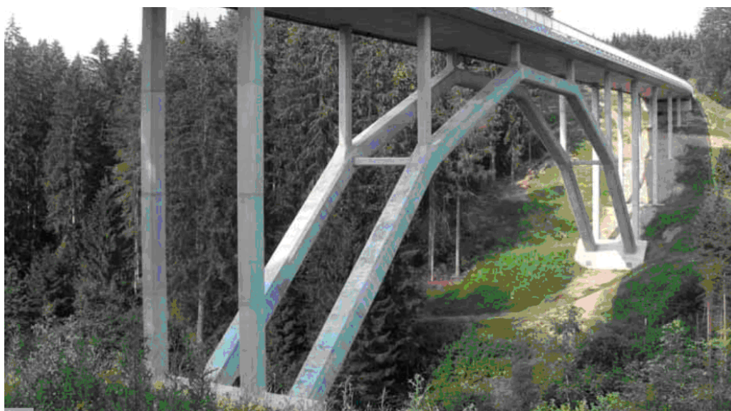
Obr. 2.5 Obloukový most ve Wildbrücke [10].
