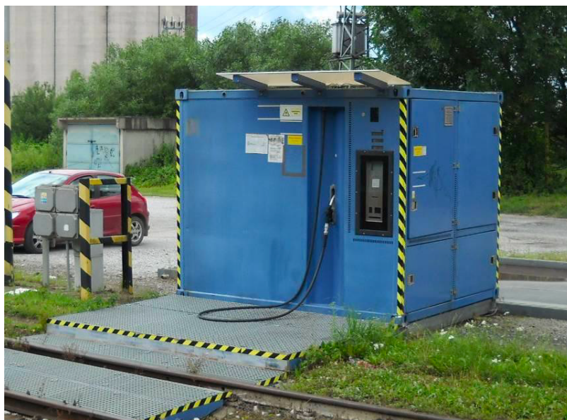
Obrázek 6 - ukázka umístění samoobslužné neveřejné čerpací stanice; zdroj: http://www.petroleum.cz/upload/aprochem2009_173.pdf
