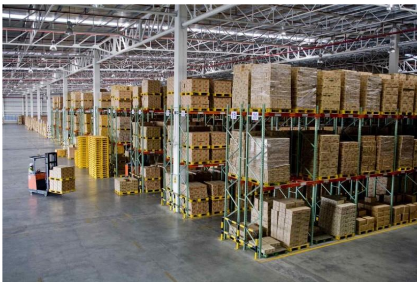
Obrázek 17: Úložný prostor v logistickém centru Damu, Almaty 51
