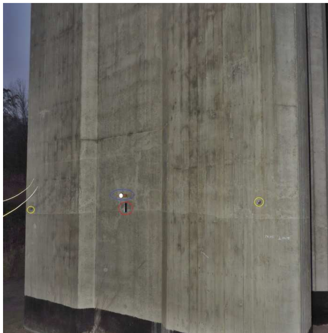
Obrázek 1.2: Fotografie jednotlivých měřících bodů: žlutá – nivelační čepy, modrá – odrazné zrcátko pro měření totální stanicí, červená – plocha pro nasazení náklonoměru (Zdroj: Technická zpráva)
