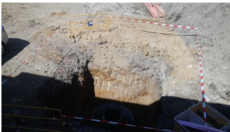
Obr. č. 11 Ohrazení výkopu páskou, zdroj: vlastní zdroj
