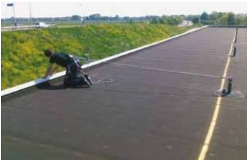
Obr. č. 19 Zádržný systém s ocelovým lankem, zdroj: vyrobkyprostavbu.cz
