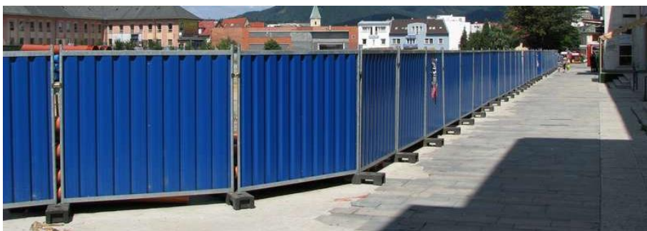
Obr. č. 2 Neprůhledné oplocení staveniště, zdroj: zariadeniestaveniska.sk
