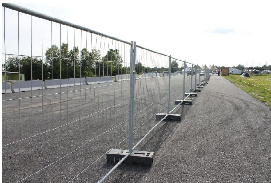
Obr. č. 4 Průhledné oplocení staveniště, zdroj: dixi-wc.cz
