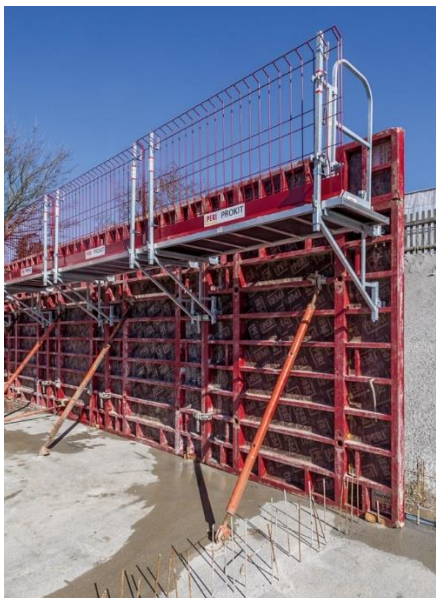
Obr. č. 15 Pracovní lávka, zdroj: dumabyt.cz
