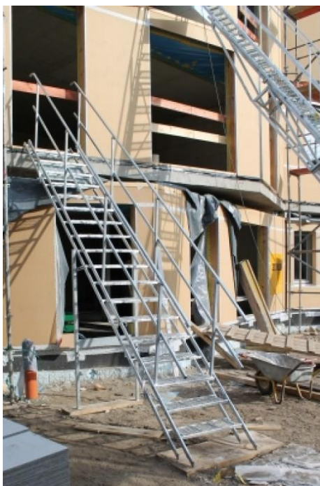
Obr. č. 13 Schodišťová věž, zdroj: Tvstav.cz
