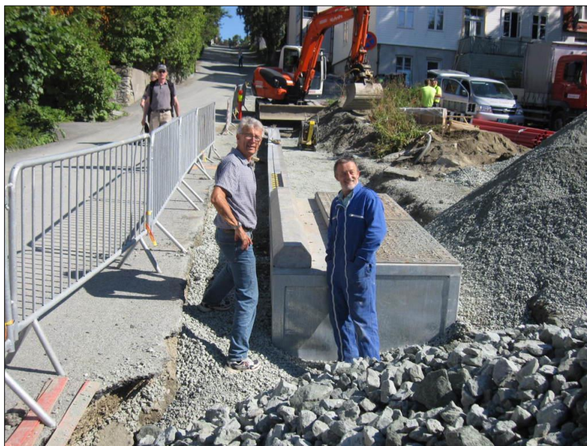
Obrázek 3-4 Jarle Wanvik (v popředí vlevo) při výstavbě výtahu [24]
