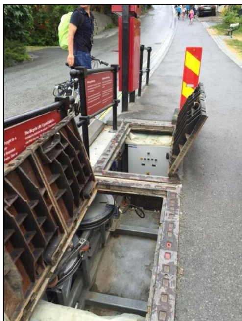
Obrázek 5-1 Strojovna výtahu [36]
