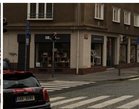
Obr. D33 – Přechod pro chodce, jižní rameno; nevyhovující snížený obrubník
