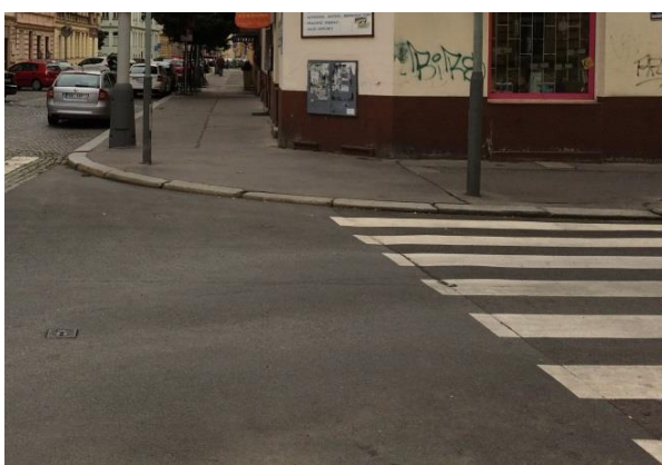
Obr. D32 – SZ náměstí, přechody pro chodce bez hmatových a bezbariérových úprav
