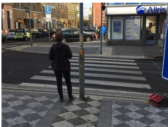
Obr. D22 – Přejchod pro chodce, severní rameno; hmatové a bezbariérové úpravy v pořádku
