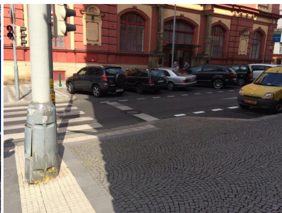
Obr. D23 – Východní rameno, parkovací pruh dotažen až k přechodu
