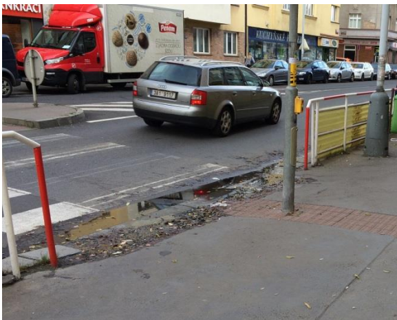
Obr. D101 – Čekací plocha západ; zanedbaná údržba – varovný pás je téměř celý skrytý
