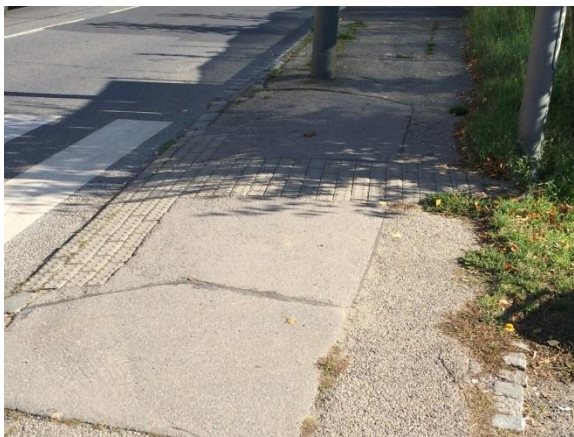
Obr. D93 – Čekací plocha západ; signální pás doveden k nedostatečné vodící linii
