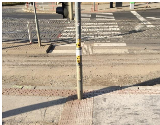
Obr. D88 – Přejchod pro chodce, východní rameno (fotografie pořizena během rekonstrukce)
