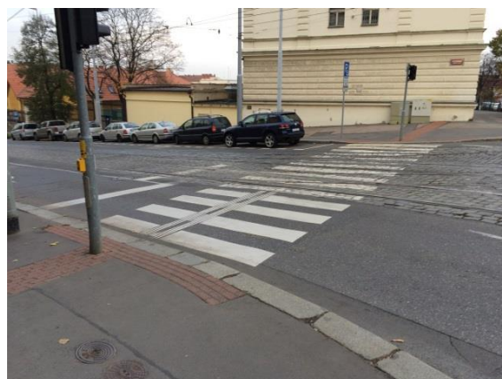
Obr. D68 – Přejchod pro chodce, severní rameno
