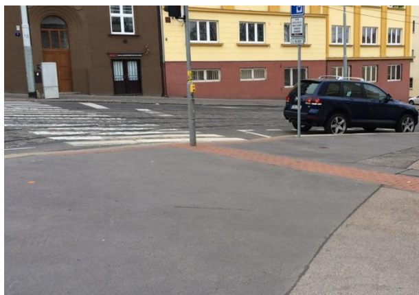
Obr. D66 – Hmatové a bezbariérové úpravy, SV nároží
