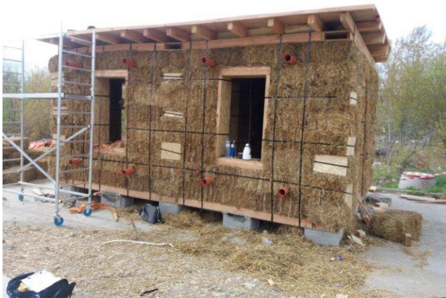
Obr. 11: Experimentální objekt „Slamák“ s neomítnutými slaměnými stěnami
