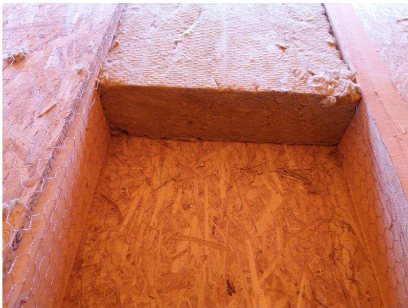
Obr. 10: Ukládání minerální izolace do "kapes" pletiva mezi trámy
