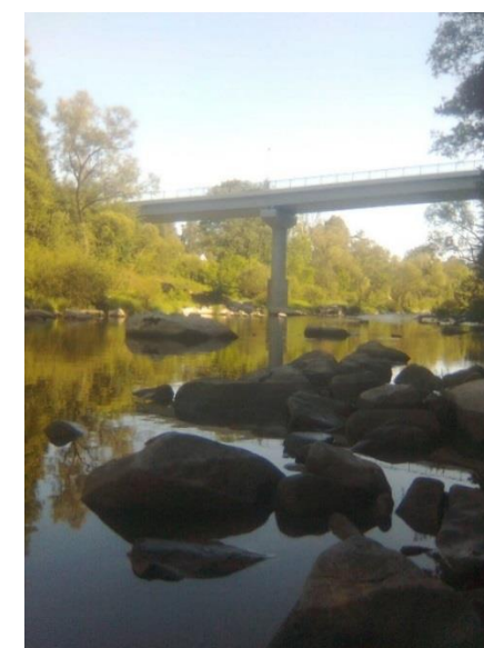
Foto 102. Balvanité koryto řeky se silničním mostem v Krhanicích (17)
