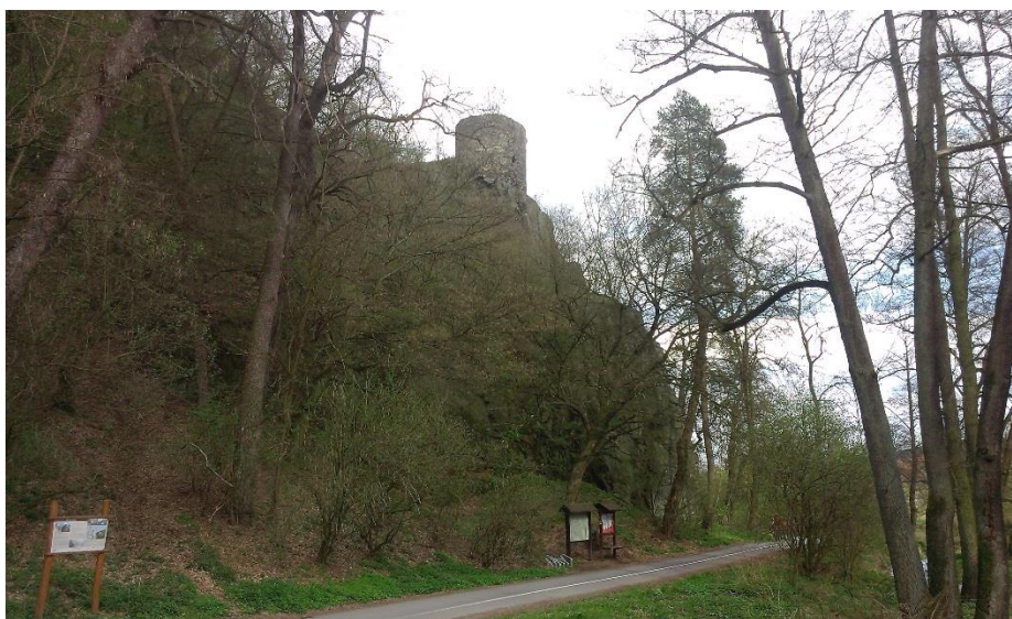
Foto 20. Pohled z cyklostezky na stráň se Zbořeným Kostelcem (3)
