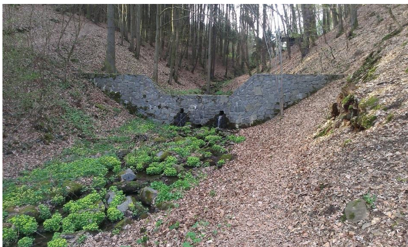
Foto 51. Přeliv Ledeckého potoka s údolím (19)
