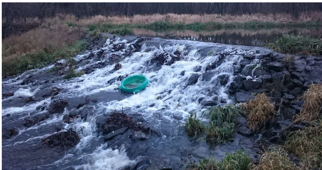
Obr. 6: Detail opravy jezu z levého břehu
