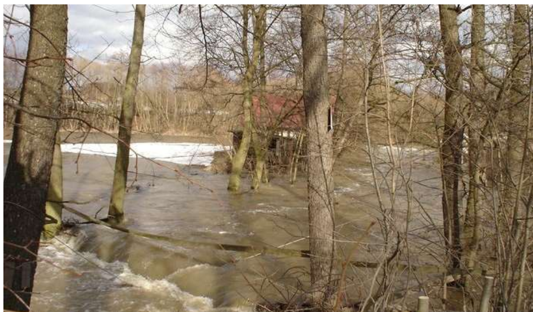
Obr. 9: Pohled na MVE a okolí jezu během povodně 2006 [6]
