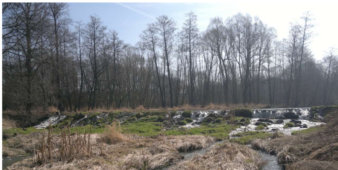
Obr. 4: Celkový pohled na jez [6]
