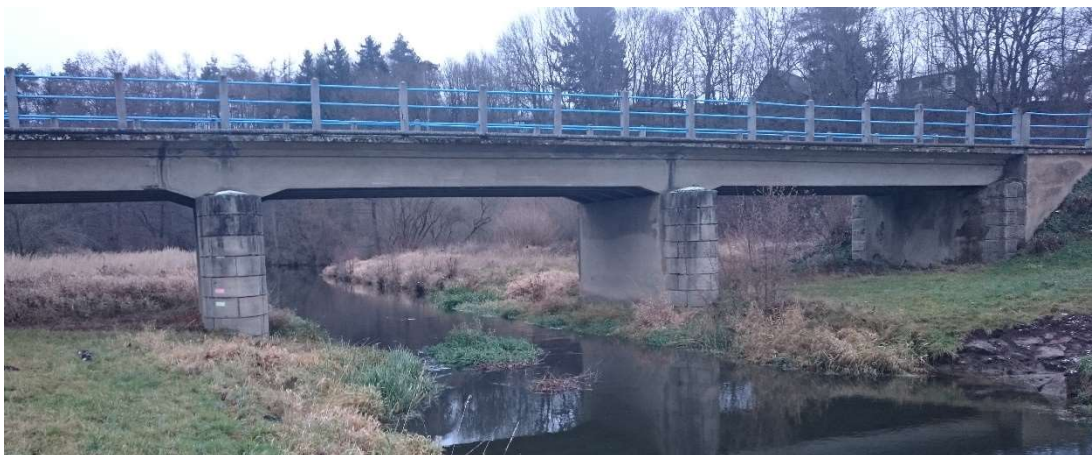
Obr. 11: Silniční most v Kamberku
