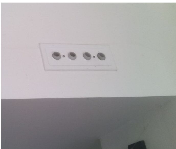
Obrázek č. 32 a 33: Pohled na distribuční elementy v pokoji a řídicí jednotka na toaletě [46]
