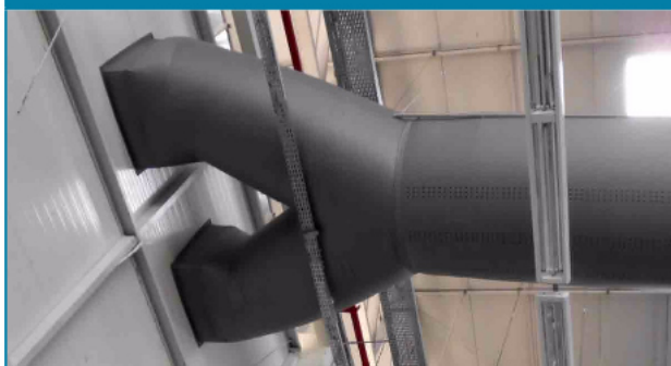
Příklad připojení vyústky k přívodu vzduchu
