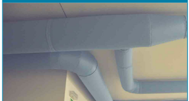
Příklad vedení vzduchu tkaninovým potrubím
