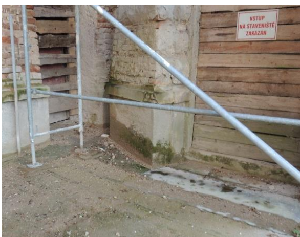
Zemní vlhkost soklové oblasti spolu s biologickou degradací.
