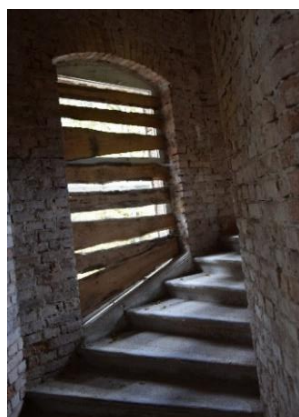
Interiér schodišťové osmiúhelníkové věže.
