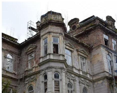
Výplně otvorů z exteriéru
