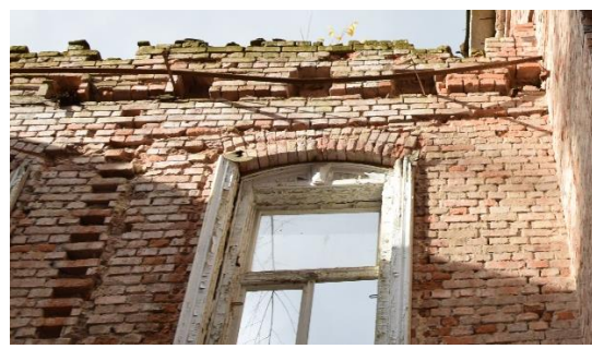
Překlad tvořený cihelným zaklenutím 2.02
