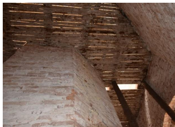
Pohled na stropní konstrukci nad 3.NP osmiúhelníkové věže.
