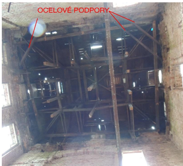
obrázek 19 Krov střešní báně
