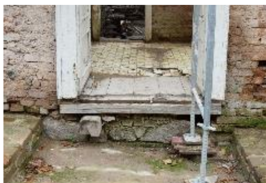
Pohled z 2.16 do 2.10 viditelné dřevěné stropní trámy a podlahové souvrství.
