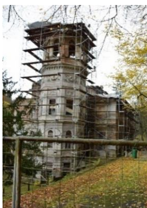
Pohled na schodišťovou osmiúhelníkovou věž.
