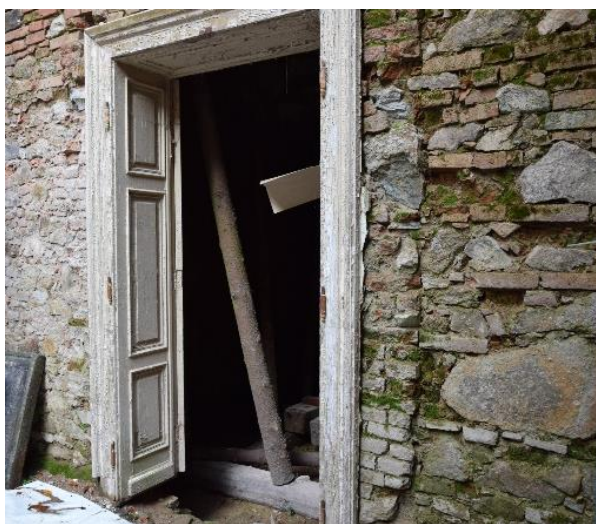
Smíšené zdivo původního lázeňského objektu v 1.09
