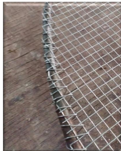
Obr. 90: Napínání síťového podkladu
