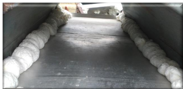
Obr. 76: Redukce po utěsnění
