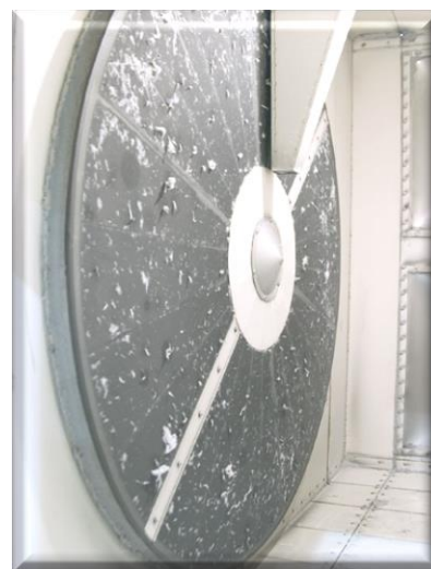
Obr. 22: Filtrační kolo s odsávacím ramenem [7]
