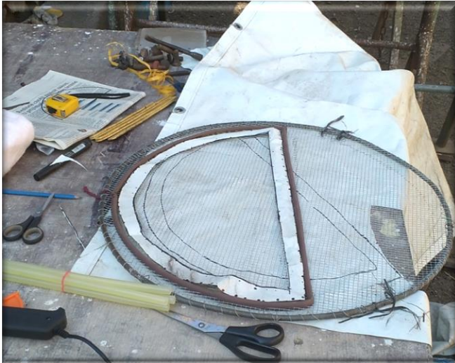
Obr. 94: Lepení podkladního PVC
