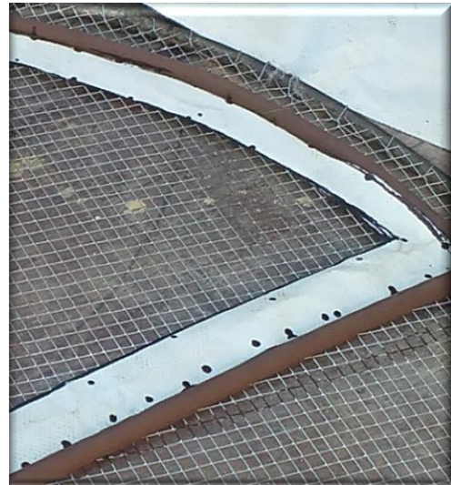
Obr. 95: Detail uchycení podkladního PVC
