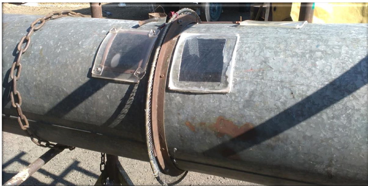
Obr. 83: Revizní otvory před dokončením
