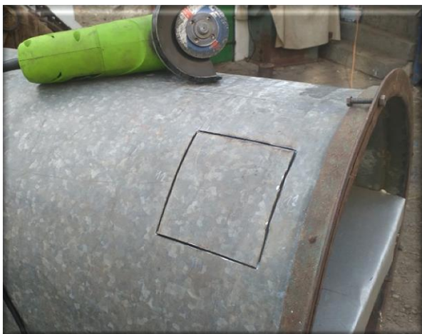
Obr. 81: Tvorba revizního okna
