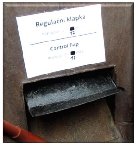
Obr. 45: Manuální regulační klapka
