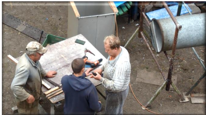
Obr. 136: Stavba zkušební tratě
