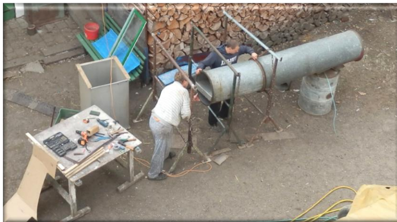
Obr. 137: Stavba zkušební tratě
