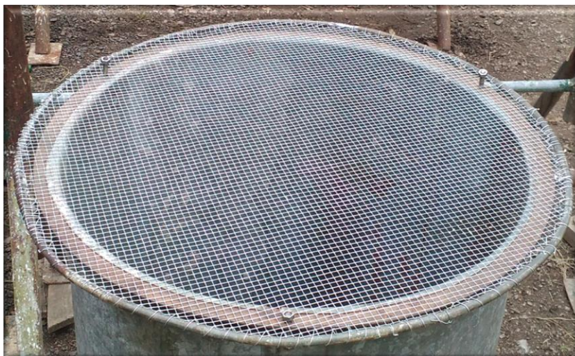
Obr. 91: Vystředění filtrační vložky na VZT potrubí
