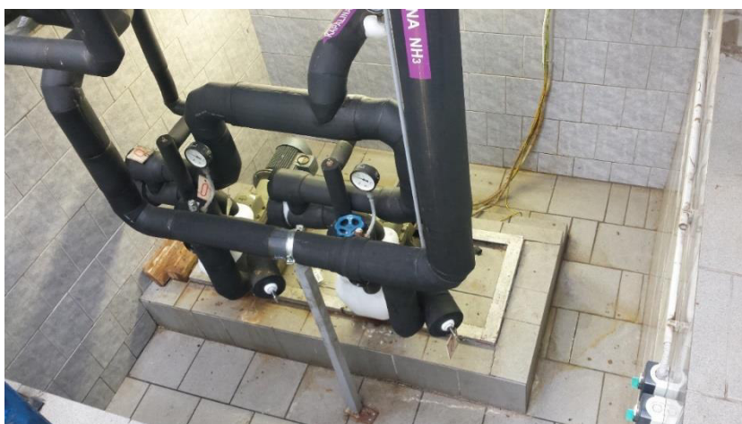
Obr. 21 Nádrž pod expanzní nádobou – zachycení úniku čpavku
