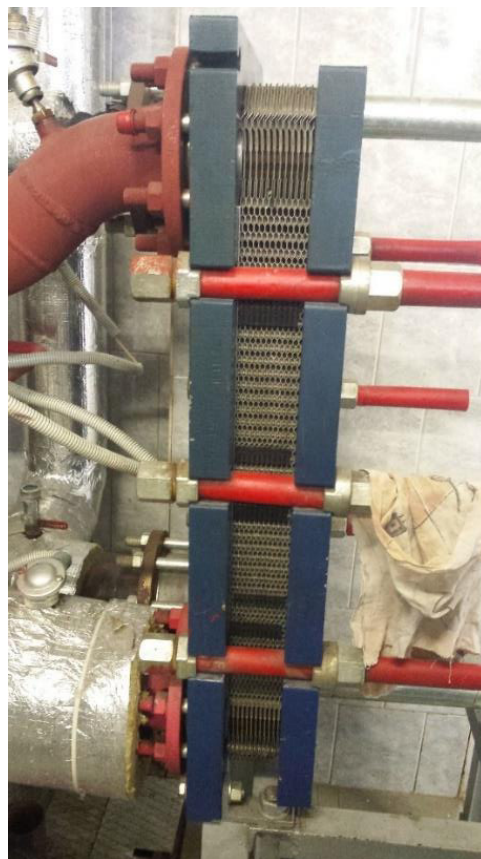
Obr. 19 Výměník tepla čpavek-voda
