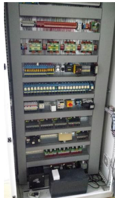
Obr. 15 Řídicí jednotka chlazení
