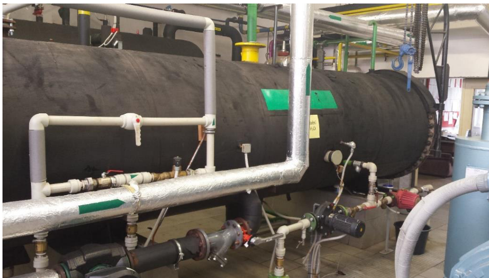
Obr. 24 Akumulační nádrž H 2 O – objem 10 m 3
