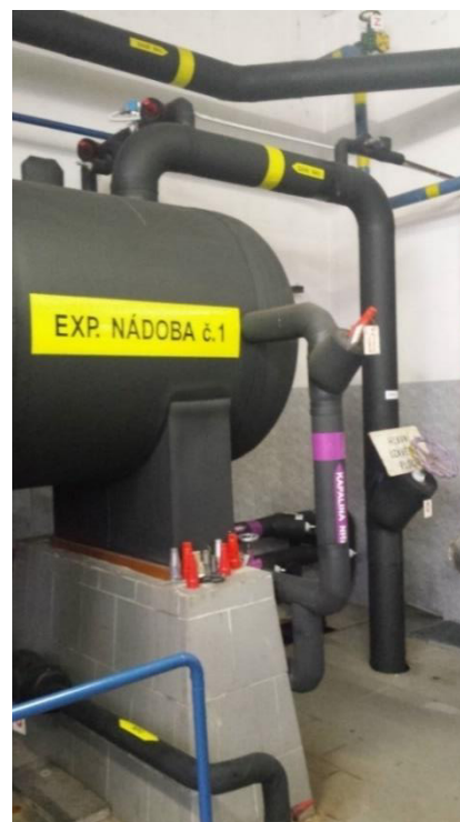
Obr. 20 Expanzní nádoba
