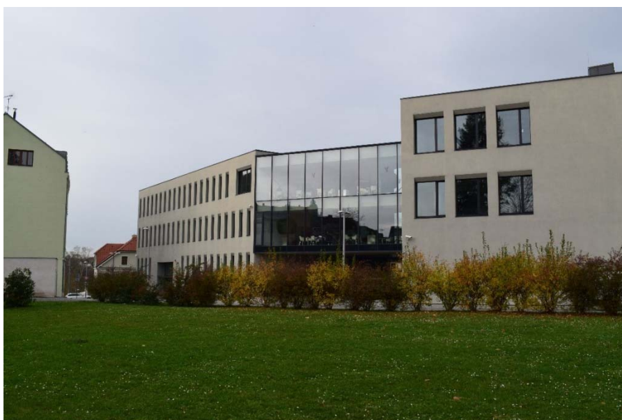
[2] Napojení budovy B (vlevo) spojovacím můstkem
