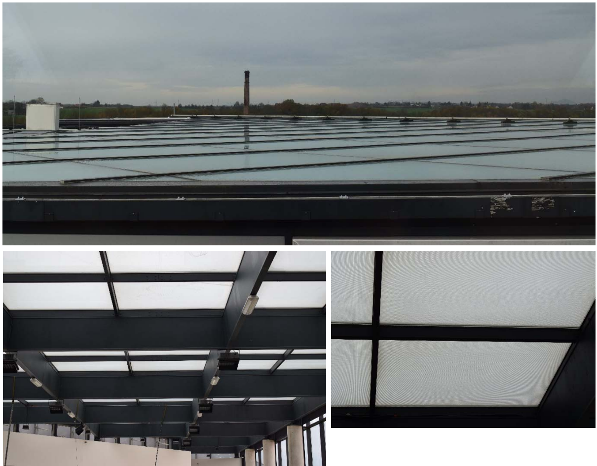
[13] Detaily prosklené střechy - pohled z exteriéru, konstrukce v interiéru a detail dílce s folií
