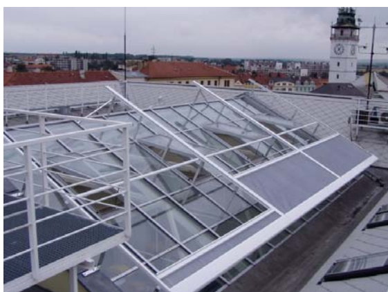
[38] Podobný princip uvažovaného stínění střechy, který je použit u světlíku
